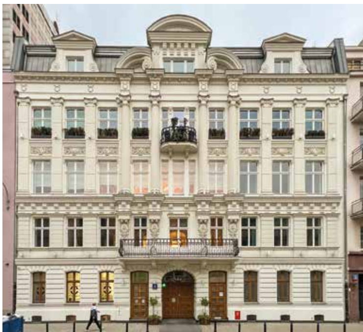
Budynek przy ul. św. Barbary 4 (1903), zrekonstruowany w zakresie partii zwieńczenia i dachu w latach 2016-2018, z wykorzystaniem poddasza na funkcje użytkowe poprzez podniesienie kąta nachylenia połączy dachowych trakcie podwórzowym. Fot. W. Kmieć
