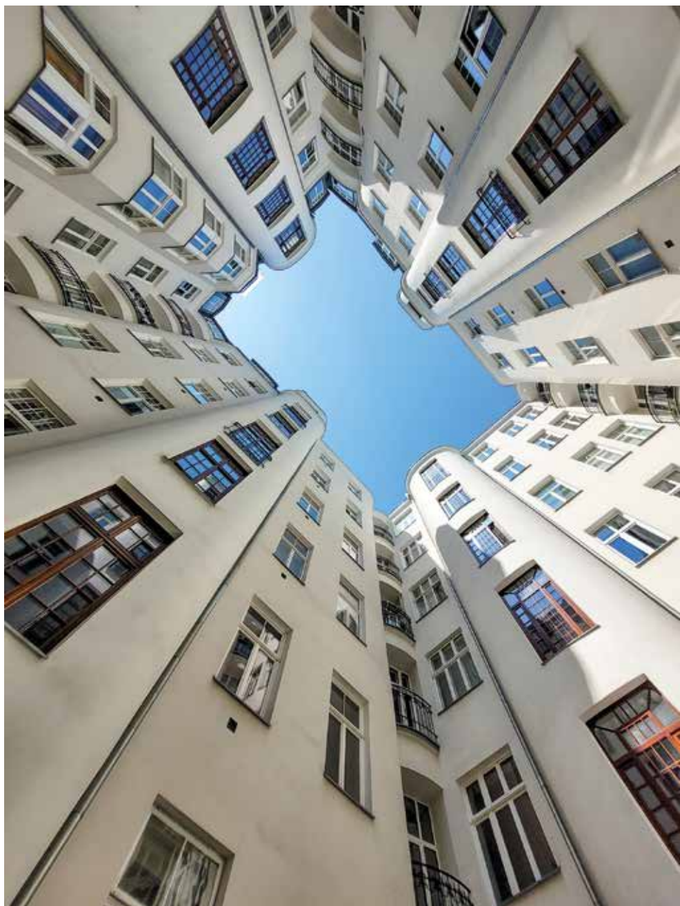
Dusza podwórka kamienicy przy ul. Wilczej 8 (proj. Wacław Heppen i Józef Napoleon Czerwiński). Fot. J.S. Majewski
