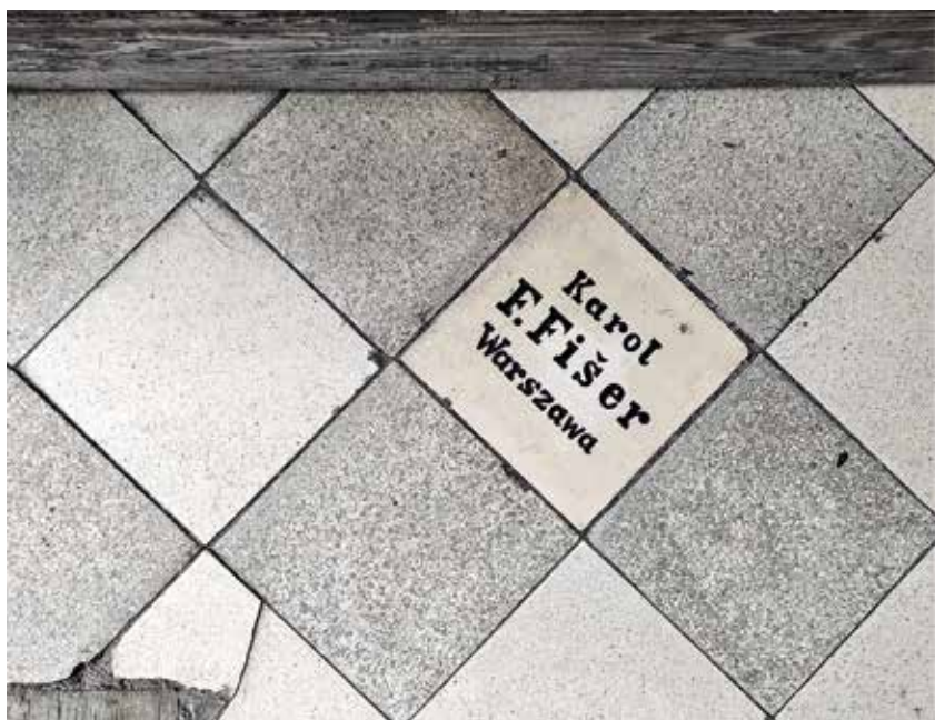
Płytki sygnaturowa posadzkowa firmy Karola F. Fišera w kamienicy przy ul. Chmielnej 10A, podest przed biegiem wyrównawczym schodów oficyny poprzecznej (pierwotnie drugiej – w drugim podwórzu nieistniejącej dziś kamienicy frontowej). Fot. K. Komar-Michalczyk, 2021
