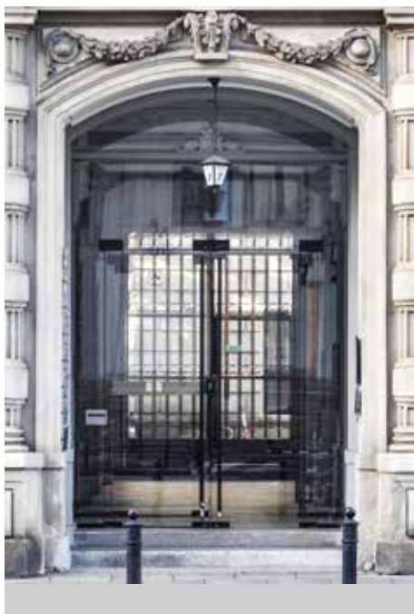
Widok przejazdów bramnych zamkniętych nowymi drzwiami ze szkła i żelaznymi szklonymi – za pomocą których ukazano cechy dekoracyjne wnętrza. Po lewej ul. Nowy Świat 7, po prawej ul. Poznańska 15. Fot. A. Cichy, K. Diks
