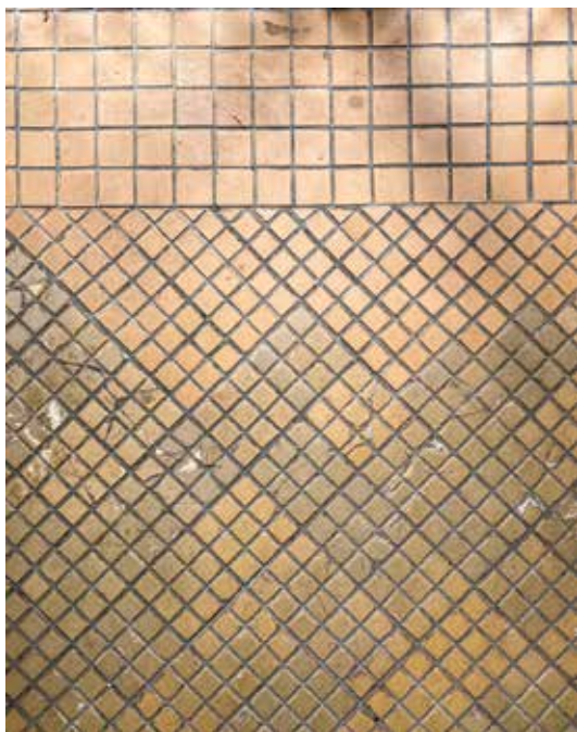
Nawierzchnia przejazdu bramnego kamienicy przy ul. Niecałej 10 – płytki historyczne uzupełniono płytkami imitującymi pierwotne. Fot. W. Kmieć
