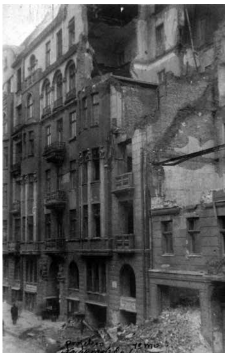
Kamienica przy ul. Nowogrodzkiej 18 (1912), częściowo uszkodzona, pozbawiona fragmentów trzeciego, czwartego i piątego piętra – stan na 1946 r. Fot. AUm.st.W, Wydż. Archiwum Biura Administracyjno-Gospodarczego Urzędu m.st. Warszawy, Akta Urzędu m.st. Warszawy, Warszawa 1945-1975, sygn. 15/2083
