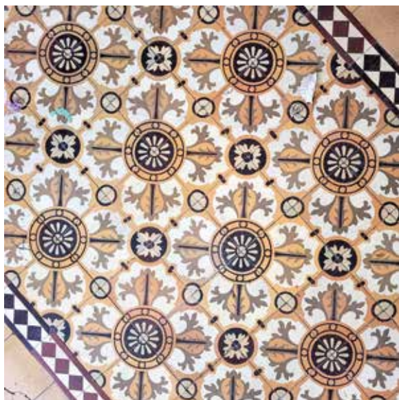
Płytki terakotowe na posadzce podestu klatki schodowej kamienicy przy ul. Tamka 37. Fot. J.S. Majewski
