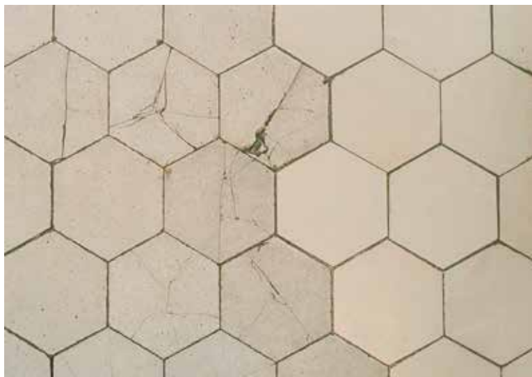
Płytki posadzkowe na głównej klatce schodowej kamienicy przy ul. Próżnej 12, po lewej stronie historyczne, po prawej współczesne. Fot. W. Kmieć
