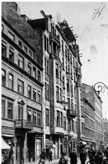
Dom czynszowy przy ul. Chmielnej 26 (1913), spalony, pozbawiony dachu i części stropów, częściowo uszkodzony, pozbawiony fragmentów piątego piętra, zwieńczenia i dachu – stan na 1946 r. Fot. APW, 25: Biuro Odbudowy Stolicy, Warszawa 1945-1951, sygn. 4460, s. 59
