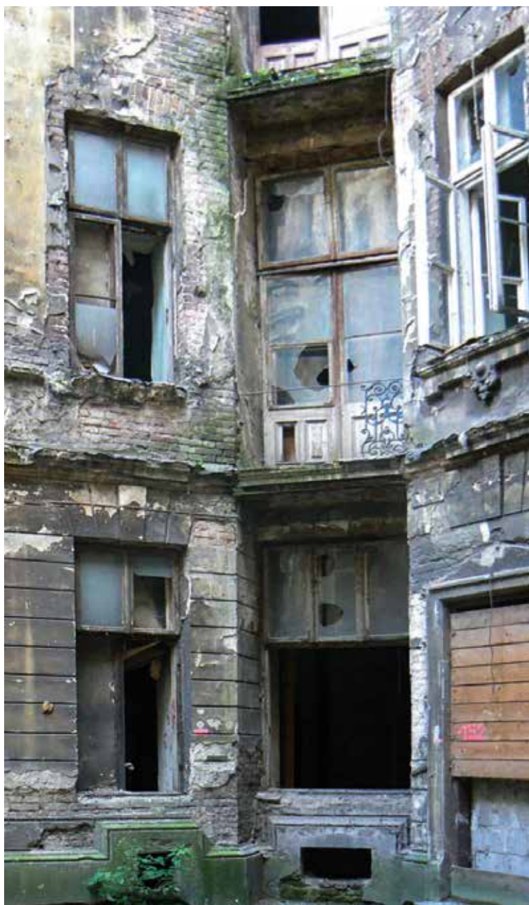
Fragment elewacji podwórzowej kamienicy przy ul. Foksal 13 przed rozpoczęciem prac remontowych
