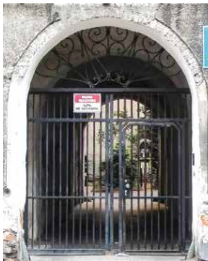
Przykłady nowych żelaznych drzwi kratowych z kamienicy przy ul. Kępczej 4, 6, 8. Fot. A. Cichy
