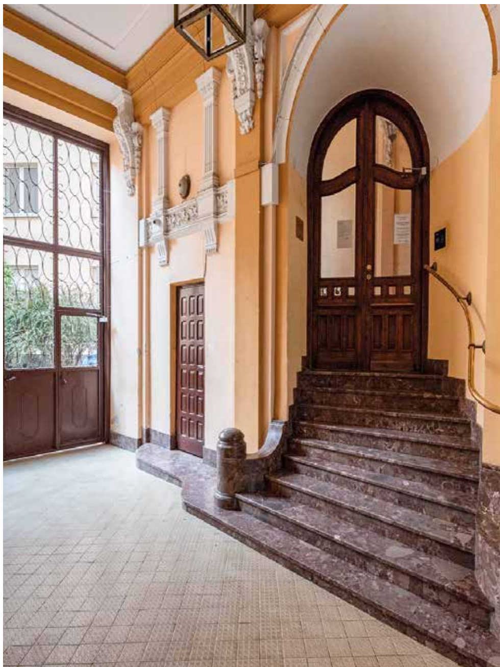
Rozbudowany, pałacowy przejazd bramny wczesnomodernistycznej kamienicy przy ul. Mokotowskiej 61 (1910-1912, proj. Marian Kontkiewicz [?]). Fot. J.S. Majewski
