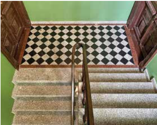
Podesty głównej klatki schodowej kamienicy przy ul. Targowej 61 – stan przed skuciem historycznych cementowych płytek oraz w trakcie „remontu” (2019) i współcześnie, tj. z pokryciem z płytek granitowych niemających nic wspólnego z pierwotnymi (2024). Fot. K. Komar-Michalczyk, W. Kmieć
