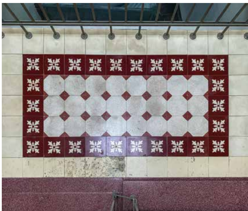
Podesty głównej klatki schodowej (z przejazdu bramnego) kamienicy przy ul. Noakowskiego 16 – wyłożone płytkami współczesnymi, których układ i kolor oraz wzór bordiury odbiegają od realizacji pierwotnej. Fot. K. Diks, W. Kmieć
