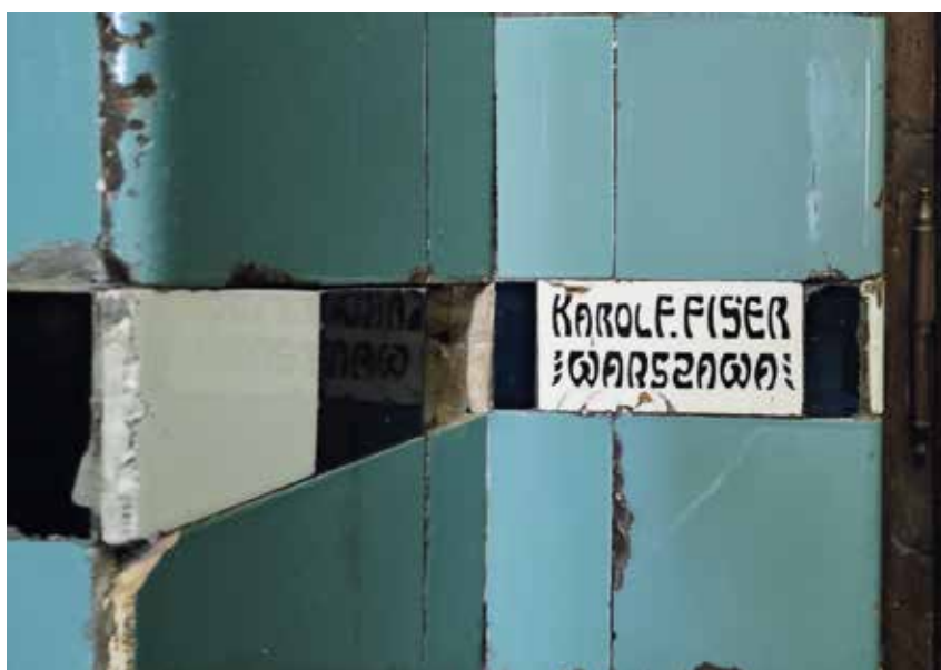
Płytki sygnaturowa ścienna firmy Karola F. Fišera, ceramiczna okładzina ściany holu w parterze kamienicy przy ul. Pięknej 47. Fot. K. Komar-Michalczyk, 2023
