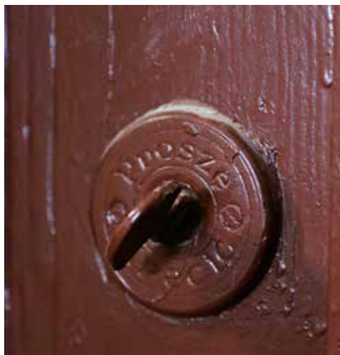
„Nakręcany” dzwonek zachowany w drzwiach do mieszkania w oficynie kamienicy przy ul. Noakowskiego 12. Fot. J.S. Majewski
