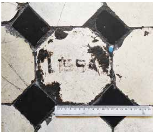
Rewers płytki Mosaikplattenfabrik Deutsch Lissa (D.T. Lissa; dziś Leśnica – osiedle w zach. części Wrocławia) – posadzka w północnej oficynie pałacu Branickich, ul. Krakowskie Przedmieście 18/20. Fot. K. Komar-Michalczyk
