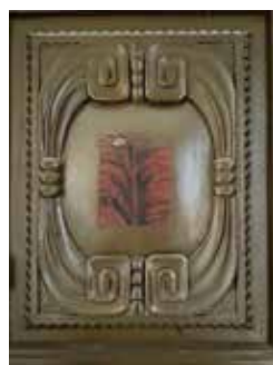
Stolarka drzewiwa klatki schodowej kamienicy przy ul. Targowej 84. W odkrywkach widoczny jest malarski mazerunek, czyli malarska imitacja drewna. Fot. K. Diks, K. Onisk
