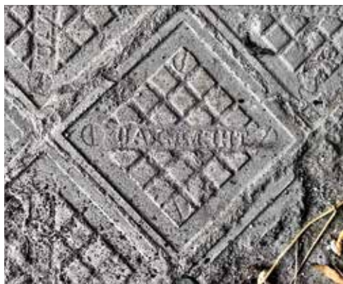
Odbicia w zaprawie płytek posadzkowych Tonwarenfabrik z miejscowości niegdyś o nazwie Unter-Themenau, dziś Poštorná (ob. część miasta Břeclav, Czechy) – przejazd bramny kamienicy przy ul. Żelaznej 66. Fot. K. Komar- Michalczyk, 2021
