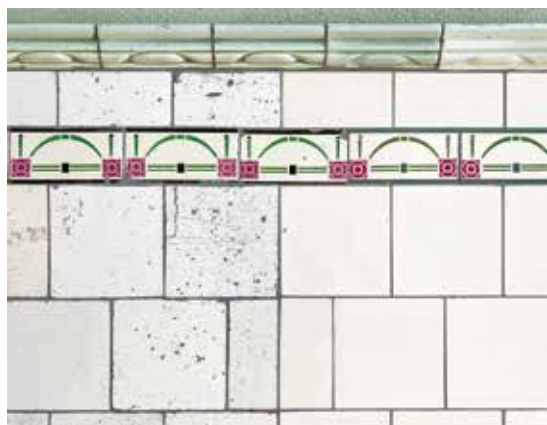
Okładzina ceramiczna ścian przejazdu bramnego kamienicy przy ul. Brzeskiej 18 – po prawej stronie kadru płytki współczesne na wzór pierwotnych. Fot. W. Kmieć
