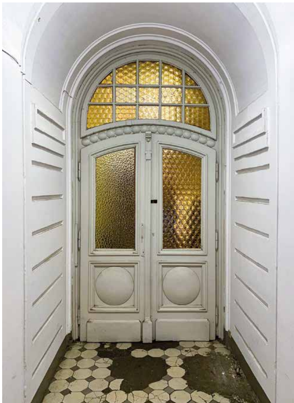
Uzupełnione wylewką betonową miejsca ubytków po płytkach – kamienica przy ul. Brackiej 18. Fot. W. Kmieć
