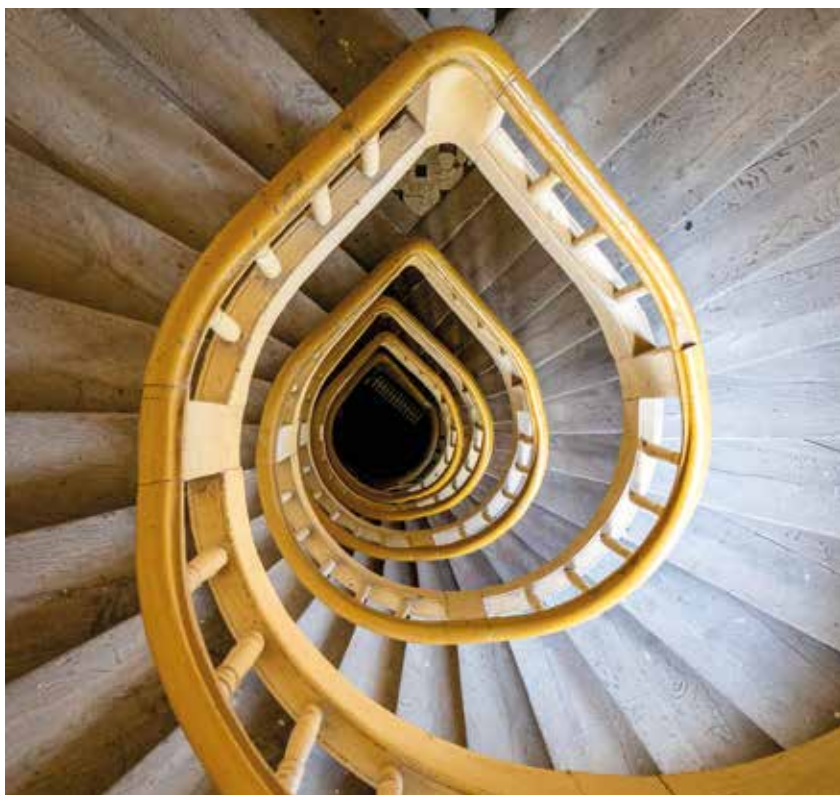
Spiralna, kuchenna klatka schodowa w oficynie kamienicy przy ul. Lwowskiej 3 (1911, proj. Henryk Stifelman i Stanisław Weiss), schody mają murowaną, niepalną konstrukcję, ale wykończone zostały drewnem. Fot. K. Diks
