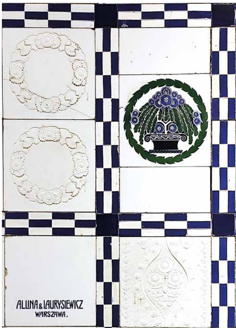
Płytką sygnaturową ścienną firmy Allina & Laurysiewicz w obrębie ceramicznej okładziny ściennej z udziałem płytek Rakonitzer Schamottewaren-, Mosaikplatten- und Ofenfabrik „RAKO” w Rakonitz (Rakovnik, ob. Republika Czeska), łaźnia Pod Messalką, ul. Krakowskie Przedmieście 16/18. Fot. K. Komar-Michalczyk, 2021
