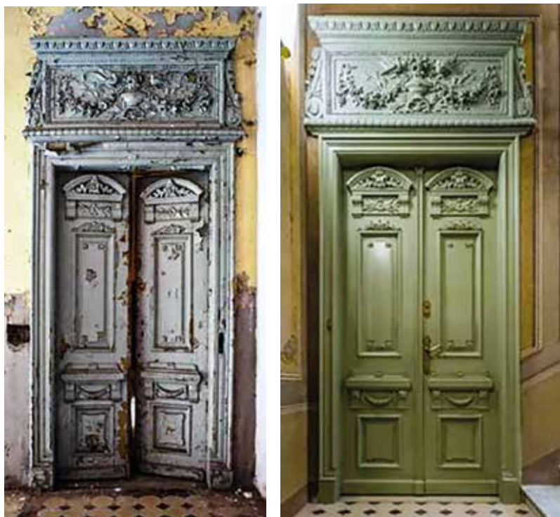
Klatka schodowa w kamienicy przy ul. Foksal 15. Na fotografiach ukazano drzwi drewniane z supraportą – w stanie przed pracami restauratorskimi oraz po restauracji. Kolorystykę przywrócono po wykonaniu badań stratygraficznych warstw malarskich. Fot. za: M. Stacherski, Przywrócone piękno dawnej Warszawy. Niezwykła metamorfoza 120-letnich kamienic Foksal 13/15 (online), 29.09.2020, https://www.whitemad.pl/foksal_13-15_metamorfoza/ (dostęp: 10.05.2024)
