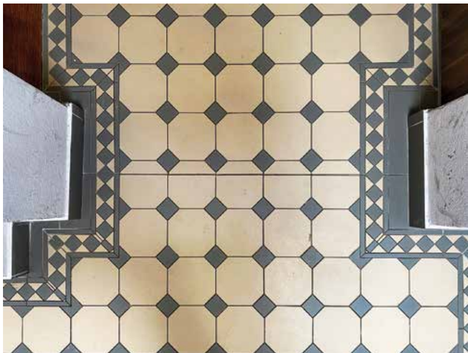
Podest klatki schodowej oficyny poprzecznej kamienicy przy ul. Małej 1 – płytki współczesne na wzór historycznych. Fot. W. Kmieć
