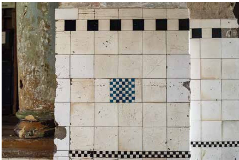
Okładzina ceramiczna ścian przejazdu bramnego kamienicy przy ul. Targowej 63 – wejście na główną klatkę schodową oraz fragment realizacji. Fot. K. Diks
