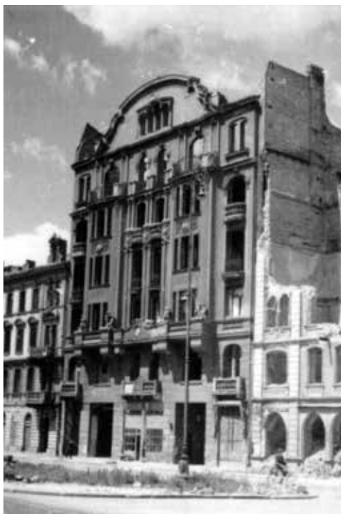
Dom dochodowy przy ul. Chłodnej 20 (1912), spalony, pozbawiony dachu i części stropów – stan na 1946 r. Fot. AZWUOZwW, Zbiory fotograficzne, Warszawa 1918-1955, sygn. 12951
