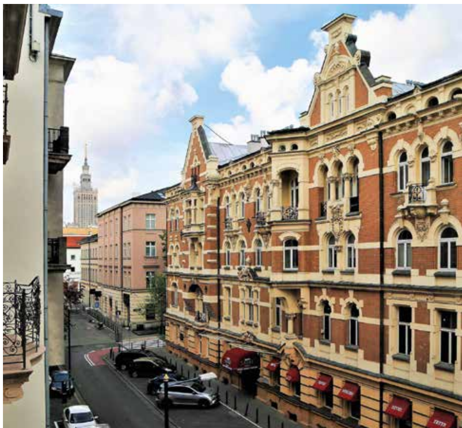
Wykończona licówką elewacja frontowa kamienicy przy ul. Foksal 16 (proj. Bronisław Brochwicz-Rogóyski. Fot. J.S. Majewski
