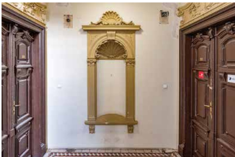
Podest piętra w kamienicy przy ul. Mokotowskiej 65, widać m.in. zachowaną stolarką drzwiową i posadzkę z terakotowych płytek. Fot. K. Diks
