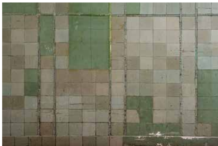
Przejazd bramny kamienicy przy ul. Żurawiej 24A – widok ogólny i zbliżenia na fragmenty okładziny ceramicznej zamalowane wówczas farbą. Fot. K. Diks
