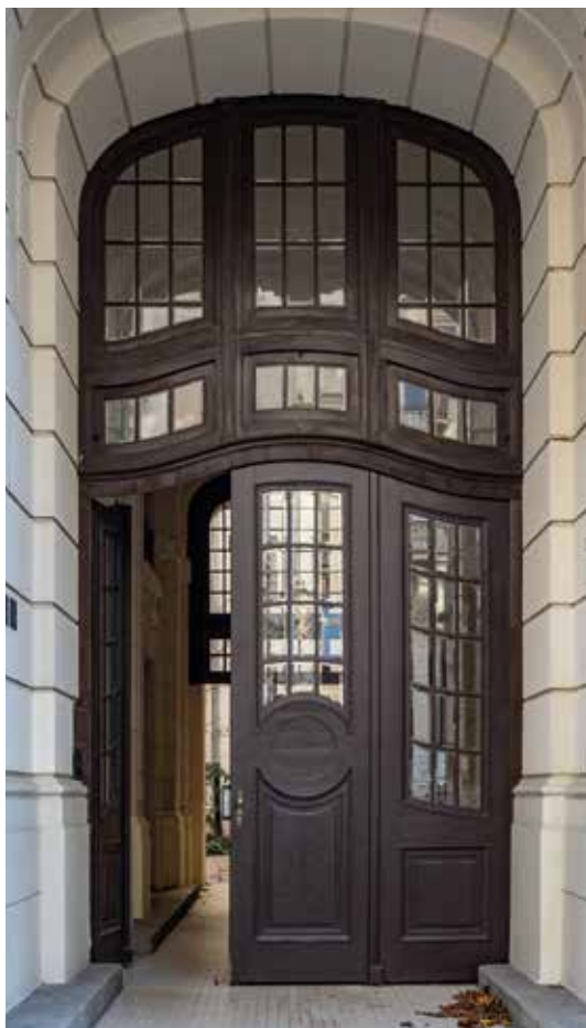
Kamienica przy ul. Bagatela 10 zachwyca wczesnomodernistycznymi drzwiami o doskonałych proporcjach, pomalowanymi na kolor ciemnobrązowy. Monumentalne, osadzone w głębi przejazdu bramnego wrota, które wznoszą się na wysokości aż dwóch kondygnacji, zyskały na lekkości dzięki szklonemu przeświłtom, stanowiącym blisko 3/4 powierzchni awersu. Fasetowane czteroboczne szyby, ujęte w szczeliny krzyżowe, pokazują zadbane dziedziniec i „zapraszają” do obiektu, w którym urodził się Krzysztof Kamil Baczyński. Fot. K. Diks
