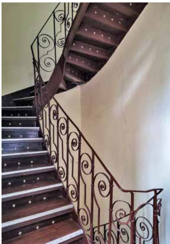
Metalowa konstrukcja schodów kuchennych wczesnomodernistycznej kamienicy przy ul. Mokotowskiej 61 (1910-1912, proj. Marian Kontkiewicz [?]). Fot. J.S. Majewski
