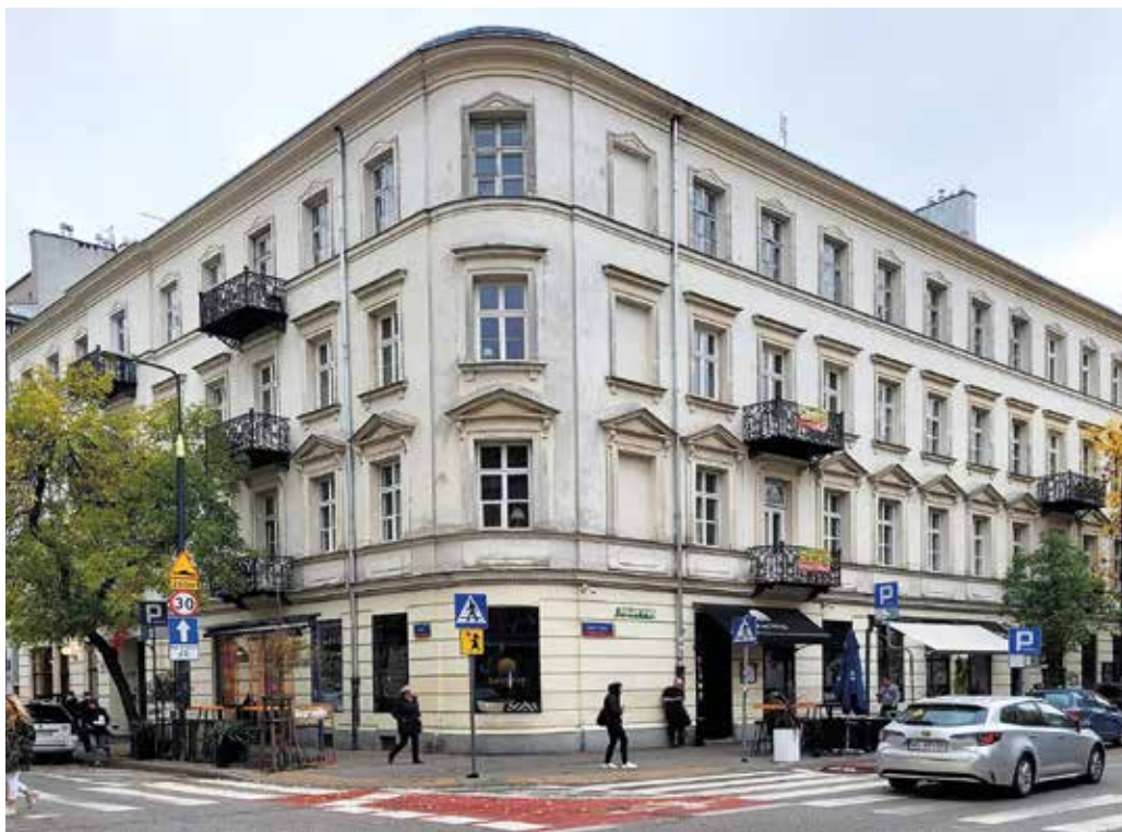
Kamienica przy ul. Hożej 61 u zbiegu z Emilii Plater / d. Leopoldyny (1882-1888). Fot. J.S. Majewski
