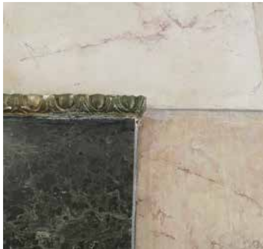
Przejazd bramny kamienicy przy ul. Noakowskiego 10, obłożony płytami stiukowymi imitującymi kamień. Niektóre detale pomalowano brązą – miały udawać powierzchnie złocone. Fot. K. Onisk
