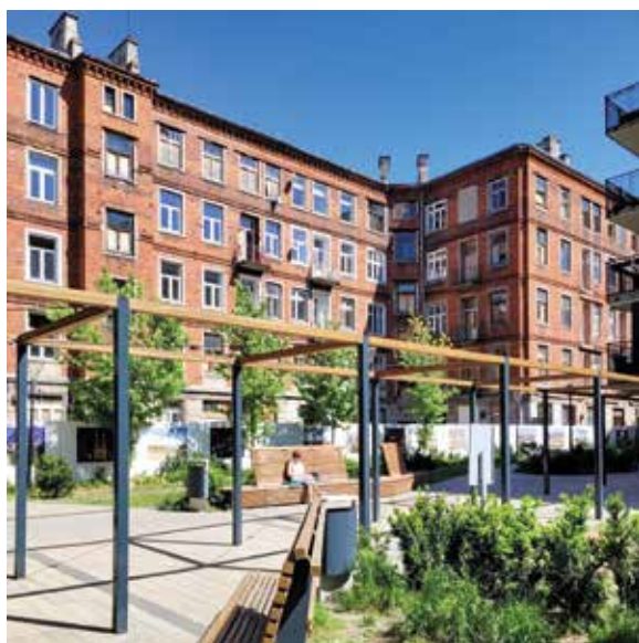
Jedna z kamienic Pachulskiego i Domańskiego przy ul. Stalowej 41 (1911-1914 r.), widok skrzydła od strony dawnego targowiska. Fot. J.S. Majewski
