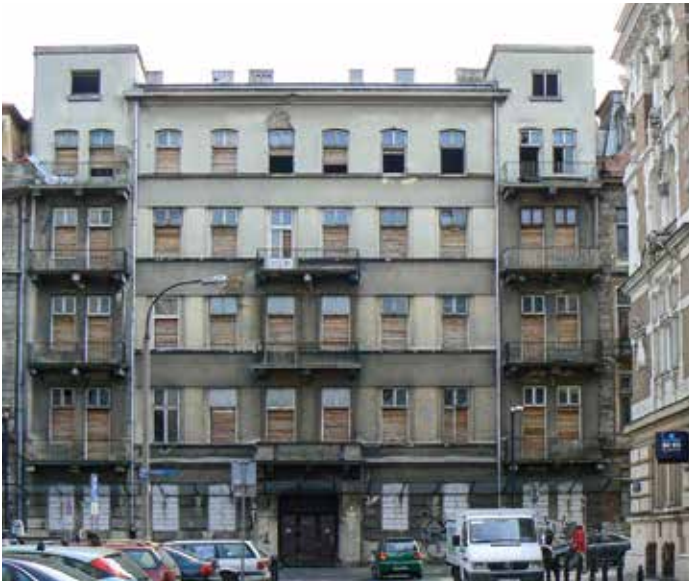
Elewacja frontowa kamienicy przy ul. Foksal 13 przed rozpoczęciem prac remontowych
