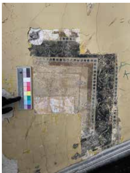
Główna klatka schodowa kamienicy przy ul. Jasnej 17, stan z 2023 r. Odkrytki ukazują spodnią warstwę dekoracji malarskiej. Aby przed remontem określić rodzaj dekoracji, należy przeprowadzić badania. Fot. K. Onisk, 2023
