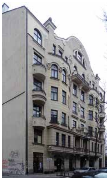
Kamienica przy ul. Emilii Plater 25 (1912), zrekonstruowana w zakresie dwóch ostatnich kondygnacji, poddasza i zwieńczenia w latach 1998-2002 – stan na 2017 r. Fot. P. Kilanowski
