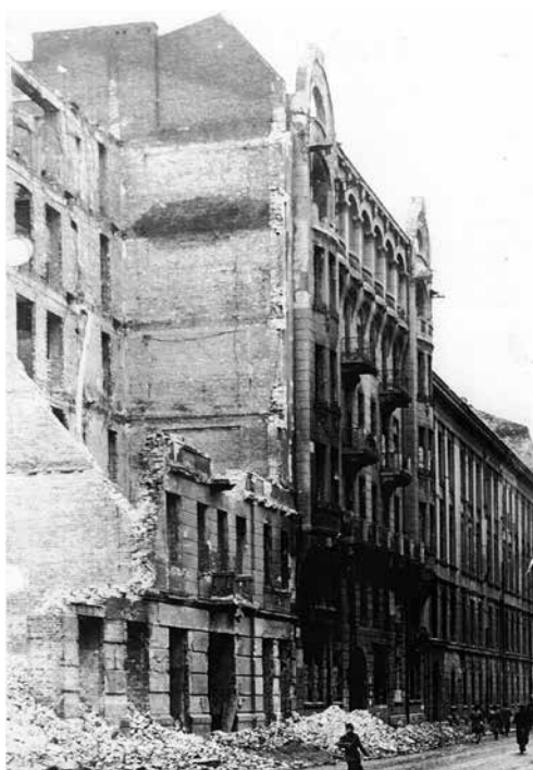
Dom dochodowy przy ul. Śniadeckich 10 (1911), pięciopiętrowy, częściowo uszkodzony, z wypalonym poddaszem i partią zwieńczenia – stan na 1946 r. Fot. AUm.st.W, Wydż. Archiwum Biura Administracyjno-Gospodarczego Urzędu m.st. Warszawy, Akta Urzędu m.st. Warszawy, Warszawa 1945-1975, sygn. 40/655
