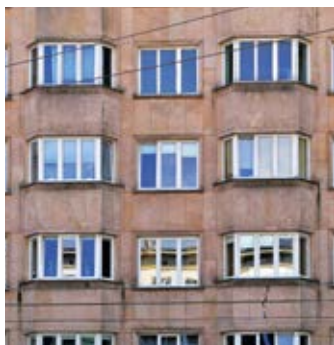
Kamienica w Al. Jerozolimskich 101. Fot. J. S. Majewski
