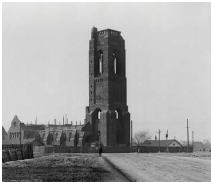
Kościół Niepokalanego Poczęcia NMP parafii św. Jakuba w trakcie budowy. Fot. Zdzisław Marcinkowski, Archiwum Warszawy
