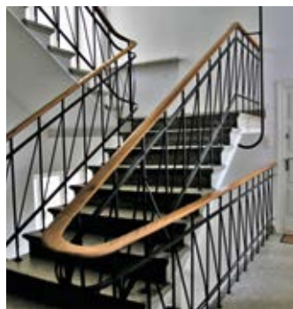
Balustrada schodów na klatce schodowej budynku przy ul. Wawelskiej 76. Fot. M. Majewski
