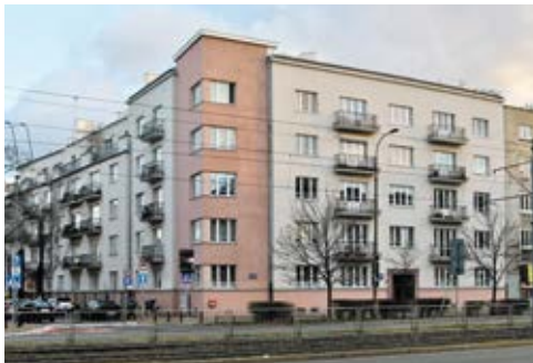
Blok „Skarbowca” przy ul. Grójeckiej 41. Różowe tynki szlachetne zastosowano w narożniku budynku. Fragmenty elewacji z tynków szlachetnych. Fot. J. S. Majewski
