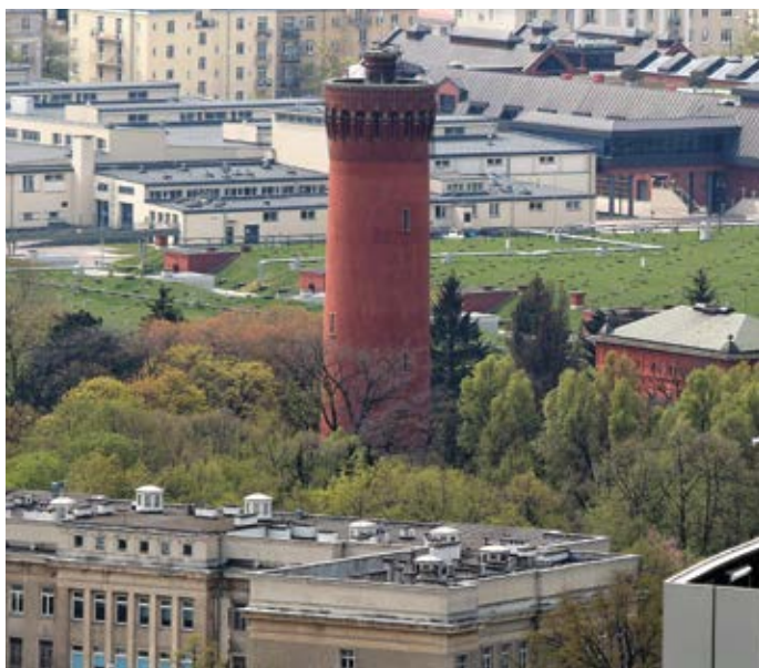
Widok na teren centralnej Stacji Filtrów. Wieża ciśnienia oraz ukryte pod ziemią grupy filtrów powolnych. Fot. J. S. Majewski
