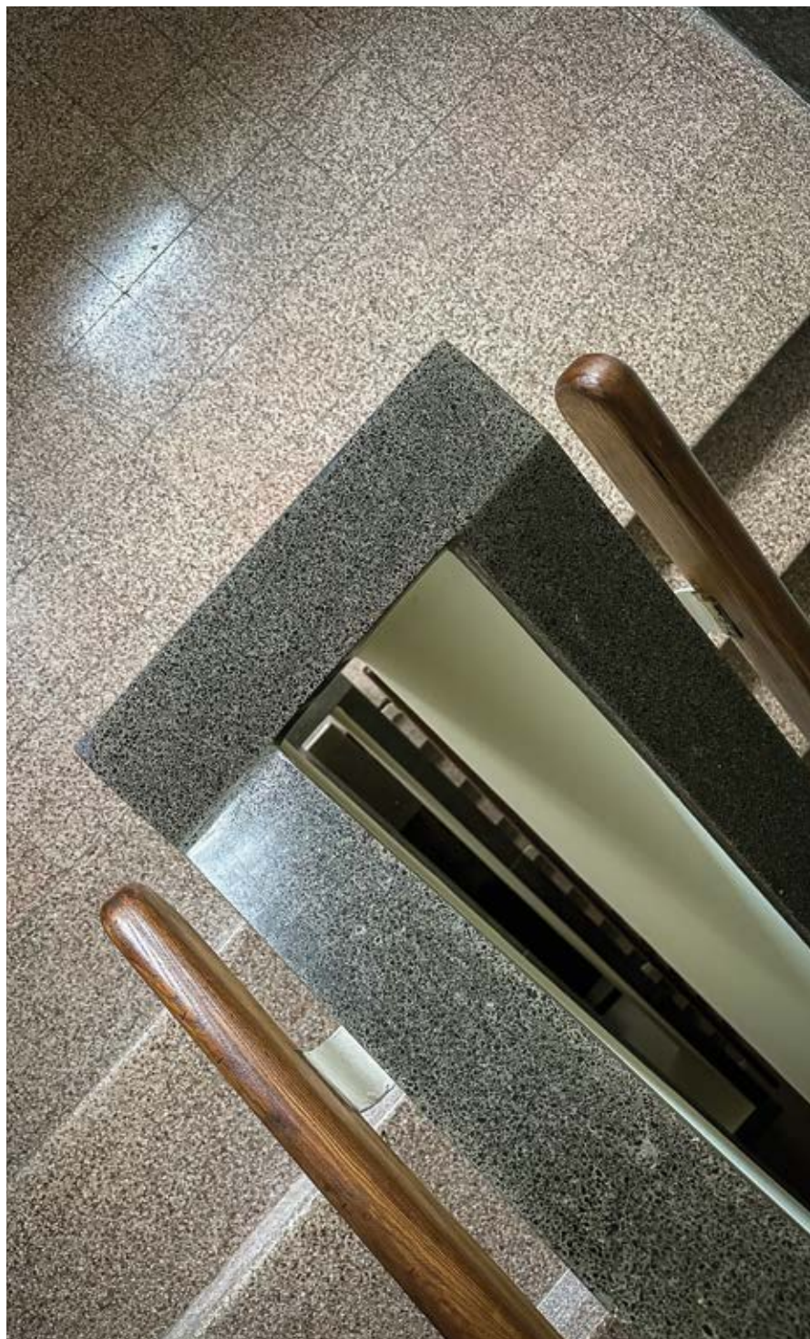
Balustrada na klatce schodowej w budynku przy ul. Niemcewicza 7/9. Fot. M. Majewski
