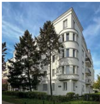
Dom przy ul. Filtrowej 81. Fot. M. Majewski
