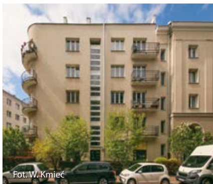
Kamienica przy ul. Kaliskiej 5
