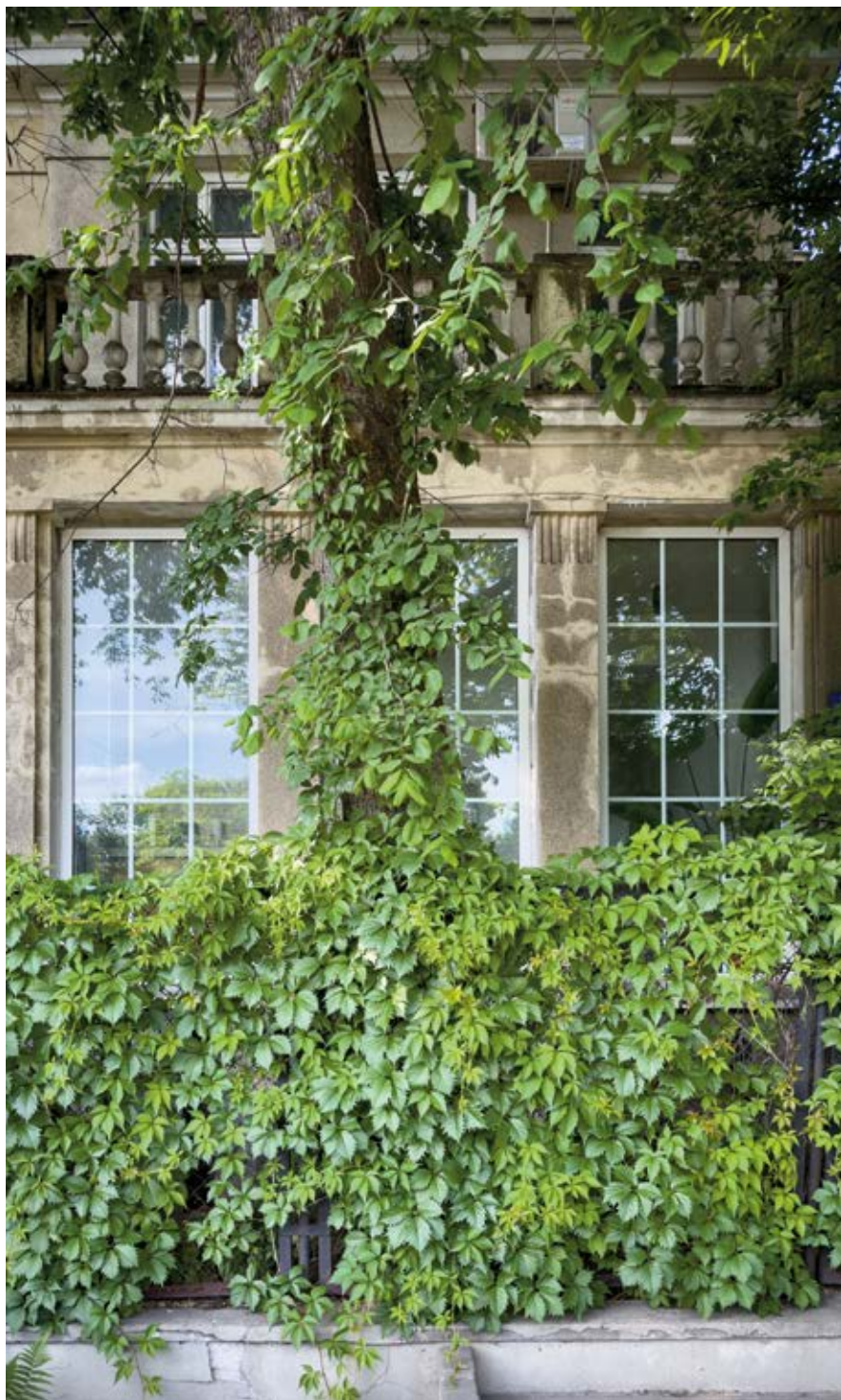
Kolonia Staszica, willa przy ulicy Wawelskiej 28. Fot. M. Majewski
