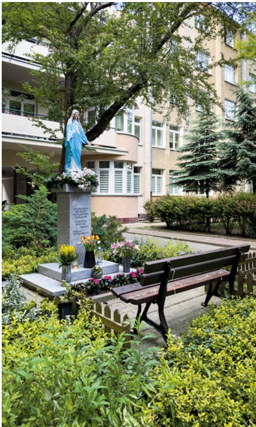
Drugi Zespól Mieszkaniowy Zakładu Ubezpieczeń Społecznych ul. Niemcewicza 7-9. Fot. M. Majewski
