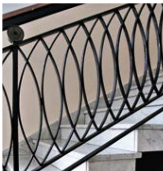
Balustrada schodów na klatce schodowej domu przy ul. Kaliskiej 9. Fot. M. Majewski
