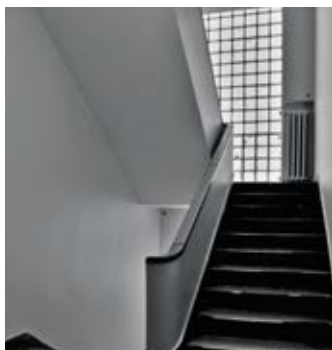
Dom przy ul. Solariego 5 Klatka schodowa oświetlona oknem termometrowym wypełnionym luksferami i ściana z luksferów. Fot. J. S. Majewski
