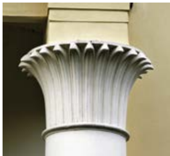
Filary o „egipskich” kapitelach kielichowych dźwigające loggię balkonową w budynku przy ul. Filtrowej 30. Fot. J. S. Majewski
