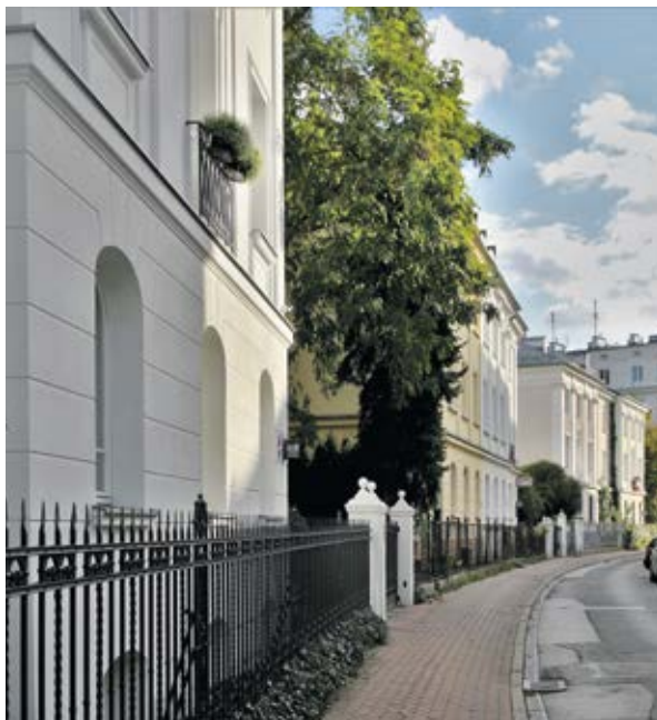
Zabudowa Kolonii Wspólnoty Mieszkaniowej Pracowników Ministerstwa Przemysłu i Handlu wzdłuż ulicy Mochnackiego. Fot. J. S. Majewski
