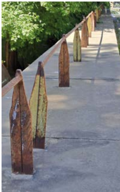
Relikty otoczenia dawnego kina Ochota – metalowe wsporniki ogrodzenia. Fot. H. Faryna-Paszkiwicz
