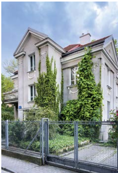
Elewacja porośnięta kokornakiem i bluszczem, Kolonia Staszica, ul. Prokuratorska 11. Fot. M. Majewski
