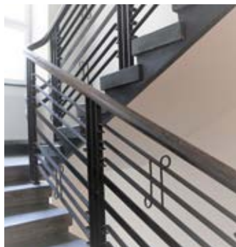
„Krakowska” balustrada w kamienicy przy ul. Grójeckiej 34. Fot. J. S. Majewski
