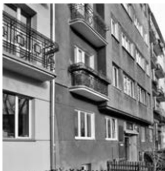
Zryzaltowana część kamienicy przy ul. Spiskiej 14. Fot. J. S. Majewski
