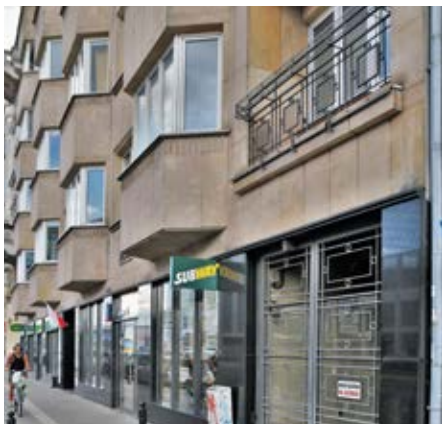
Kamienica w Alejach Jerozolimskich 101. Elewacja budynku licowana jest płytami piaskowca. W przyziemiu wprowadzono droższy rodzaj kamienia. Fot. J. S. Majewski
