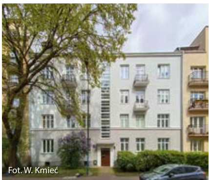
Kamienica przy ul. Węgierskiej 2 z lat 30. XX w.
