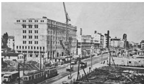
Osiedle Ochota I w budowie. Za: „Stolica”, 1953, nr 40
