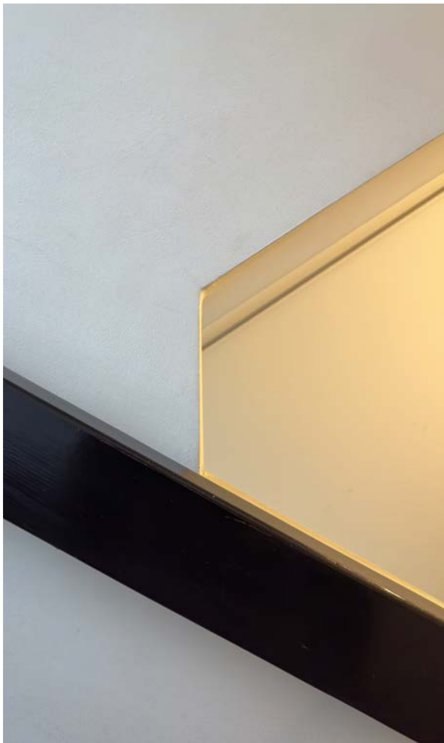
Balustrada w budynku przy ul. Grójeckiej 29. Fot. M. Majewski
