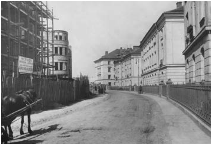
Kolonia Lubeckiego, ulica Mochneckiego i domy mieszkalne PKO, 1927 r. NAC
