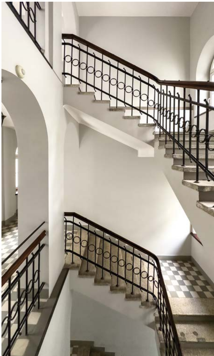
Kolonia Lubeckiego. Klatka schodowa kamienicy przy ul. Filtrowej 65, ok. 1925 r. Fot. M. Majewski
