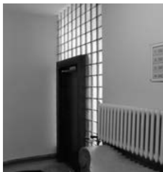
Dom przy ul. Solariego 5 Klatka schodowa oświetlona oknem termometrowym wypełnionym luksferami i ściana z luksferów. Fot. J. S. Majewski
