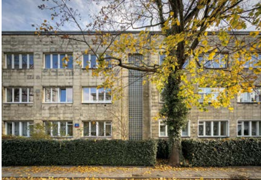
Blok FKW przy ul. Rudawskiej 4. Widać okno termometrowe z luksferami. Fot. M. Majewski
