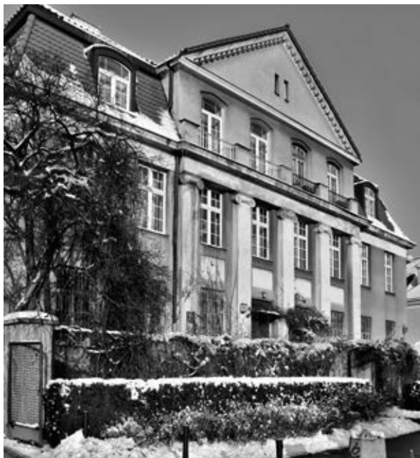
Willa miejska przy ul. Wawelskiej 22/24. Fot. J. S. Majewski
