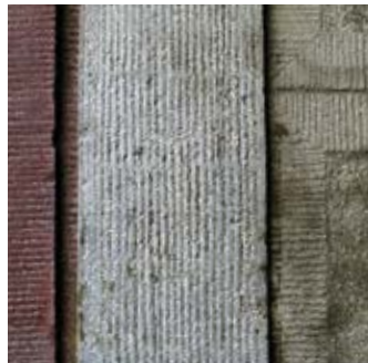
Blok „Skarbowca” przy ul. Grójeckiej 41. Różowe tynki szlachetne zastosowano w narożniku budynku. Fragmenty elewacji z tynków szlachetnych. Fot. J. S. Majewski
