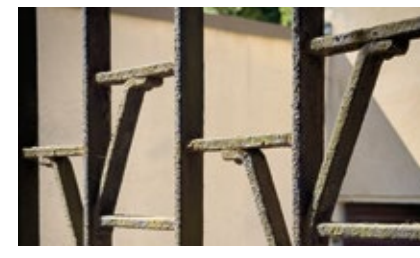
Dom przy ul. Obrońców 26, brama wykonana metodą nitowania, główki łączy płaskowników budują wzór ogrodzenia. Fot. M. Majewski
