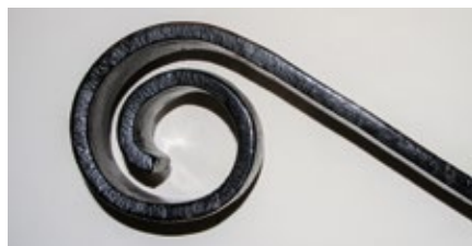
Balustrada schodów we wnętrzu
