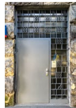
Krata przy drzwiach wejściowych domu przy ul. Berezyńskiej 16. Fot. M. Majewski
