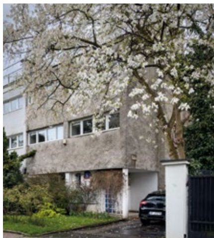
Dom przy ul. Katowickiej 11a, tynk szlachetny z dodatkiem połyskującego muskowitu; powierzchnia została obrobiona szorstko. Fot. M. Majewski
