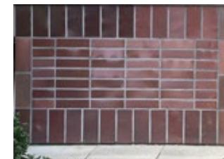
Dom przy ul. Berezyńskiej 31, przyziemie obłożone płytkami ceramicznymi. Fot. K. Onisk
