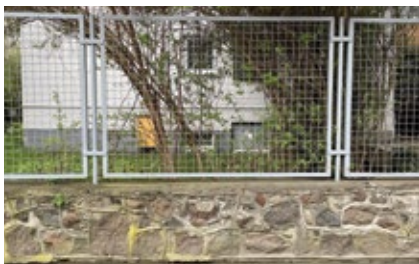
Podmurówka ogrodzenia przy ul. Bajońskiej 3-5 z bloków kamienia. Fot. K. Onisk
