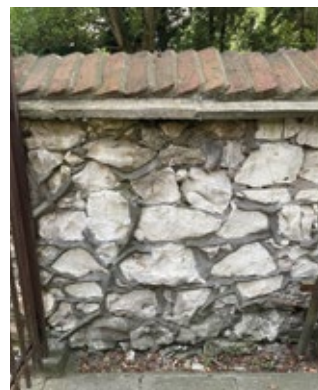
Mur ogrodzeniowy przy ul. Obrońców 36-38, z wapienia, z betonowym murkiem i okapem z dachówek ceramicznych. Fot. K. Onisk
