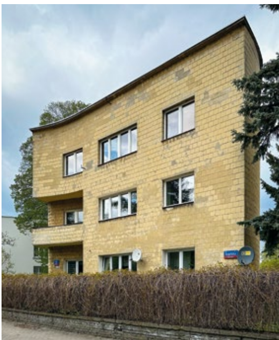
31 Domy Wolframów, ul. Bajońska 2 / ul. Paryska 3, arch. Maksymilian Goldberg i arch. Hipolit Rutkowski, I. 1938-1939 Budynek stanął na podłużnej, dość nieregularnej działce, która wpłynęła na jego ostateczny kształt. Architekci zastosowali zaokrąglenia bryły, które pozwoliły w pełni wykorzystać teren, a jednocześnie nadały gmachowi ekspresyjny charakter. Dodatkowy efekt uzyskano dzięki zastosowaniu okładziny z żółtych płytek, kontrastującej z obłożonym brązowym klinkierem cokołem. Zaokrąglone ściany akcentują wejścia do klatek schodowych, które wyróżnia również ażurowy detal. Fot. M. Majewski
