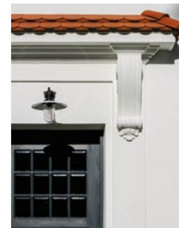
Kolonia Łaskiego – ul. Dąbrowiecka 28 – daszek kryty dachówką ceramiczną zaprojektowano na gzymsowaniu z klasycyzującym wspornikiem. Fot. W. Kmieć
