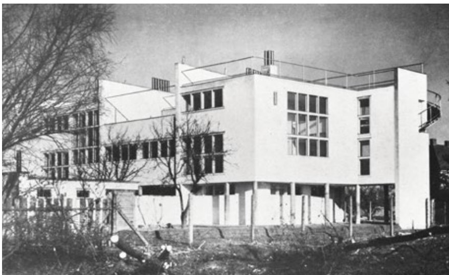
1 Willa Lachertów przy ul. Katowickiej 9/11/11a, arch. Bohdan Lachert i Józef Szanajca, stan z 1929 r. Fot. „Architektura”, 1935, zeszyt specjalny, s. 70
