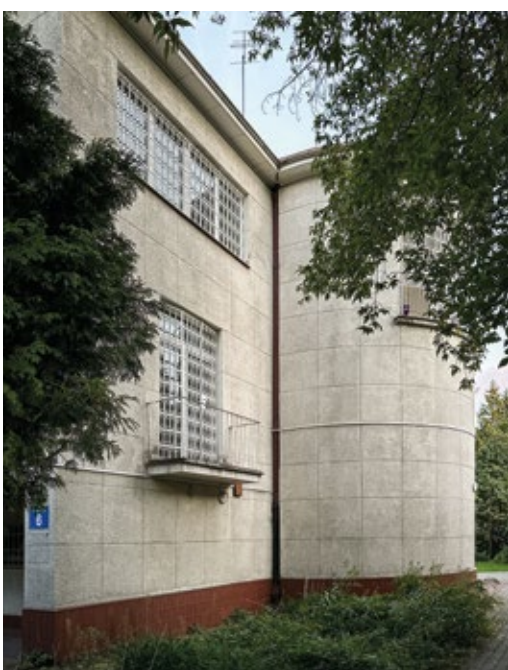
26 Willa Rotsteinów, ul. Kryniczna 6, arch. Lucjan Korngold, I. 1937-1938
