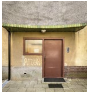
Na elewacji domu przy ul. Styki 22 położone zostały płytki szkliwe na kolor zielony. Fot. M. Majewski
