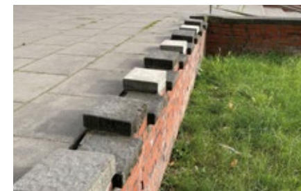
Bloki przy al. Waszyngtona 2a, mur oporowy oddzielający ciąg pieszy i zieleni wykonano z cegieł i rytmicznie ułożonych płyt betonowych. Fot. K. Onisk
