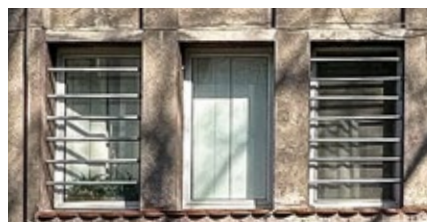
Dom przy ul. Dąbrowieckiej 27, poziomo wmurowane pręty okienne. Fot. M. Majewski
