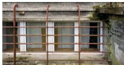
Dom przy ul. Jakubowskiej 14, balustrady i kraty wykonano z rurek i płaskownika. Fot. M. Majewski
