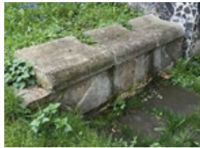
Ławeczki z siedziskiem odlanym z betonu, ulica Katowicka. Fot. K. Onisk
