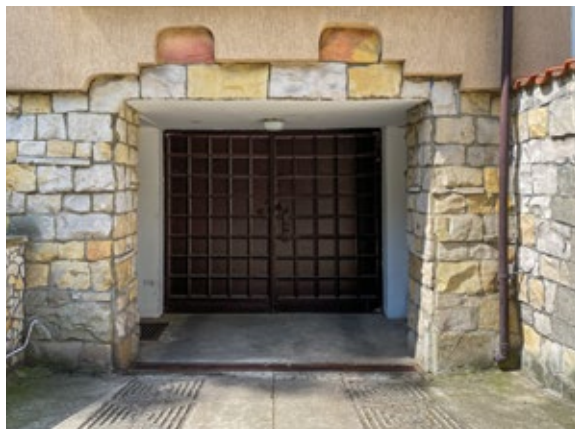
Wjazd do garażu
