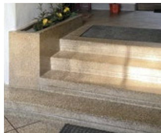
Klatka schodowa domu przy ul. Francuskiej 30, posadzka i donica z lastrika. Fot. K. Onisk
