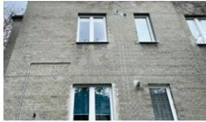
Dom przy ul. Wąchockiej 15, pełna elewacja z cegły cementowej. Fot. K. Onisk
