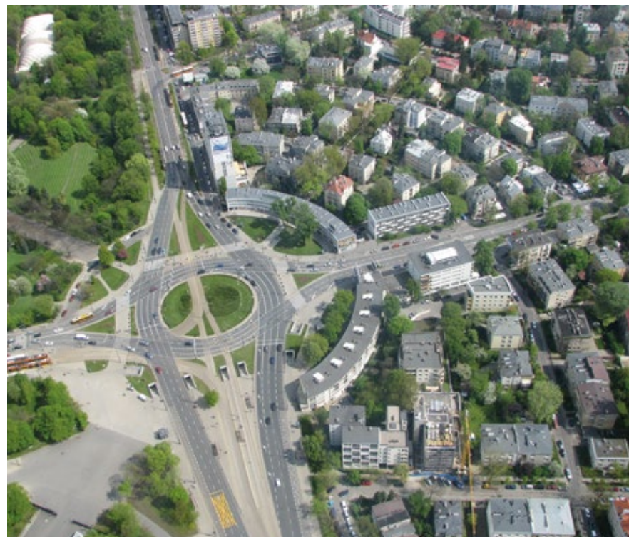
37 Budynki Spółdzielni Wspólny Dach, ul. Francuska 52, al. Waszyngtona 2a, al. Waszyngtona 2b, arch. Marek Leykam i arch. Czesław Rajewski, I. 1958-1963
