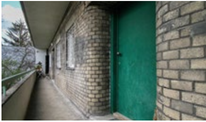
Dom przy ul. Berezyńskiej 28, cegła cementowa licująca fragment elewacji. Fot. W. Kmieć
