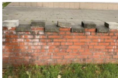
Bloki przy al. Waszyngtona 2a, mur oporowy oddzielający ciąg pieszy i zieleni wykonano z cegieł i rytmicznie ułożonych płyt betonowych. Fot. K. Onisk
