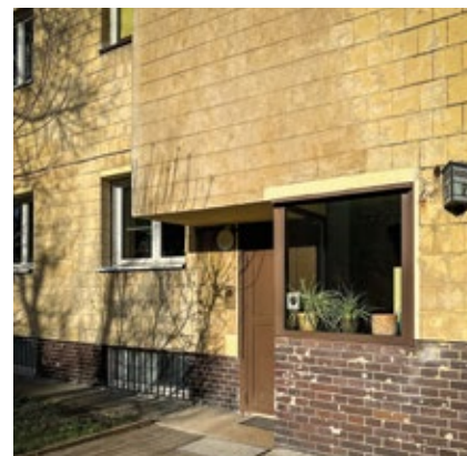
Dom przy ul. Bajońskiej 2, obłożony płytkami wykonanymi z tynku barwionego w masie; rozmiar i układ płytek współgra z innymi podziałami elewacji; część cokołową, która szybciej ulega degradacji, obłożono płytkami ceramicznymi. Fot. M. Majewski
