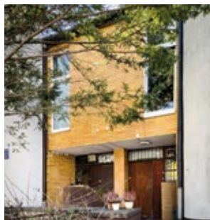
Domy przy ul. Bajońskiej 3-5 oraz przy ul. Styki 22, okładzina ceramiczna w kolorze żółtym. Fot. M. Majewski i K. Onisk
