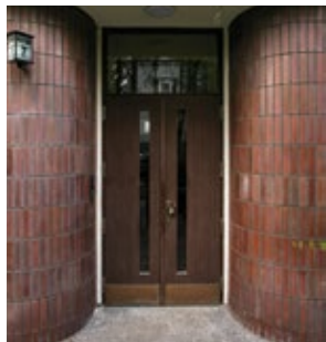
Dom przy ul. Berezynskiej 7, wejście do budynku oraz detal elewacji. Fot. W. Kmieć
