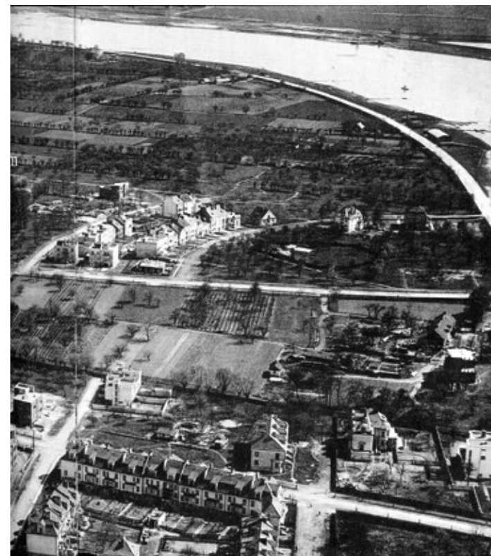
Saska Kępa ok. 1930-1931 r.; na pierwszym planie zabudowa Kolonii Łaskiego przy ulicy Obroń- ców oraz ulicy Zwycięzców i Krynicznej i Krynicznej Za: A. Rozmysło- wicz, Przedwojenna Saska Kępa , Warszawa 2016
