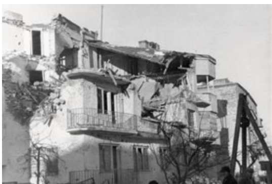
Mocno uszkodzony dom przy ul. Berezynskiej 27. Fot. Muzeum Powstania Warszawskiego
