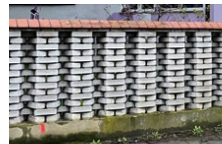
Ogrodzenie przy ul. Zakopiańskiej 16a – z białej cegły i nakryte dachówką. Fot. K. Onisk
