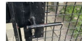
Ogrodzenie przy ul. Walecznych 36a: panele z plecionej siatki, elementy nitowane, klamka zestawiona z dwóch prętów. Fot. K. Onisk
