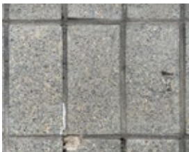
Okładzina z płytek cementowych, barwionych w masie na szarozielono, z wypełniaczem w postaci ostrokrawędzistych drobinek w kolorach żółtym, czarnym i zielonym, ul. Zwycięzców 33. Fot. K. Onisk
