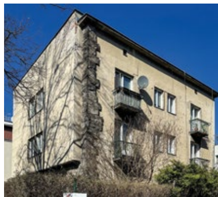
Dom przy ul. Francuskiej 38, tynk szlachetny, barwiony w masie z dodatkiem połyskującego muskowitu; płaszczyzny podzielono na pola cieniowym rowkowaniem; tynk zestawiono kontrastowo z rustykalną okładziną z piaskowca; zapewne pierwotnie tynk i kamień miały podobną barwę; obiekt wymaga konserwacji. Fot. M. Majewski
