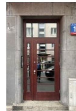
Dom przy ul. Zwycięzców 19, tynk szlachetny, barwiony w masie, imitujący okładzinę kamienną. Fot. K. Onisk
