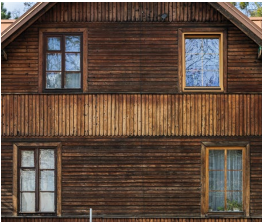
Jedyny zachowany drewniak na Saskiej Kępie, przy ul. Walecznych 37, jest świadkiem dawnej tradycji budownictwa tego terenu. Fot. W. Kmieć
