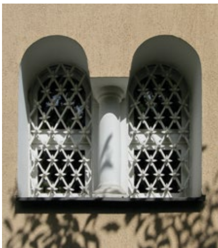
Okno biforialne w elewacji południowej
