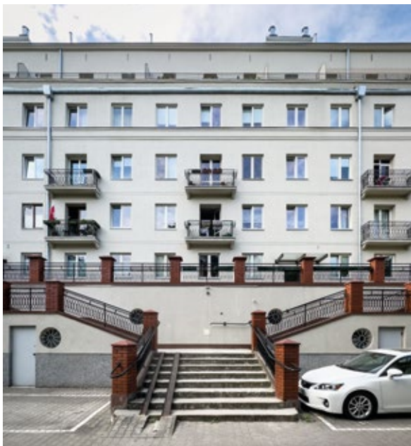
34 Domy mieszkalne pracowników Ministerstwa Żeglugi, al. Waszyngtona 30/36 i al. Waszyngtona 38/40, arch. nieznanym, ok. 1954-58
