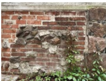
W podcieniu i ogrodzie willi przy ul. Katowickiej 9 wkomponowano głązy narzutowe, mur ceglany, płyty piaskowca mozaikę ceramiczną. Fot. K. Onisk, M. Majewski
