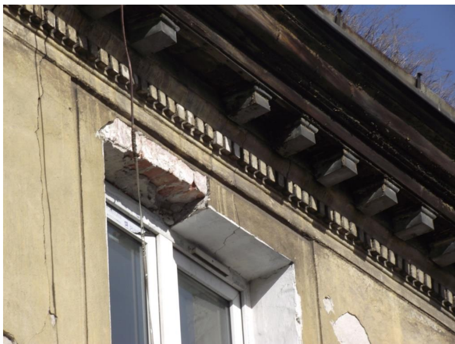
Zdj. 14. Gzyms koronujący, Targowa 14
