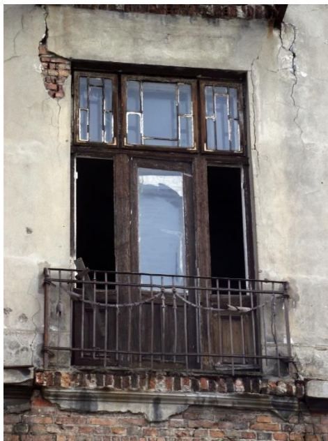
Zdj. 38. Portfenetr, Brzeska 18 (przed remontem)
