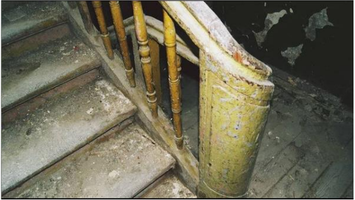
Zdj. 7. Balustrada schodów (drewniana), Targowa 19
