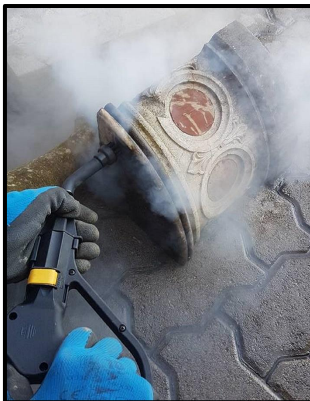
Delikatne czyszczenie powierzchni kamiennego elementu architektonicznego, pokrytego polichromią, przy użyciu przegrzanej pary wodnej podawanej pod odpowiednio regulowanym ciśnieniem
