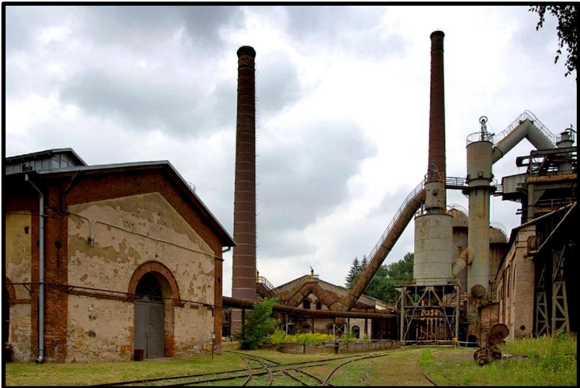
Innym przykładem zabytku architektury i techniki przemysłowej jest huta w Starachowicach
