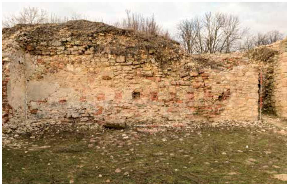
Ryc. 3.50. Ilza, zamek górny – widok na część północną dziedzińca (fot. R. Zapłata – RZ)
