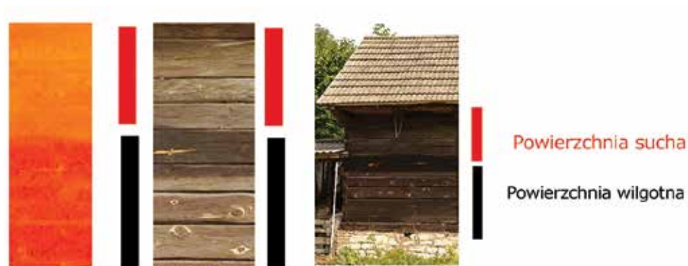
Ryc. 3.33. Iłża – fragment spichlerza drewnianego z pomiarem intensywności odbicia wiązki lasera dla powierzchni suchej oraz mokrej (oprac. R. Zapłata)
