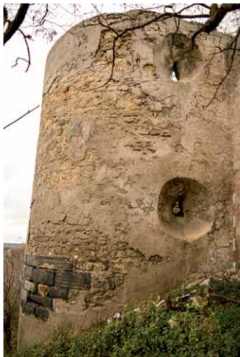
Ryc. 3.46. Ilża, zamek dolny, środkowa basteja ze strzelnicą kluczową i fragment muru kurtynowego (XVI w.), wapieni łączony zaprawą wapienno-piaskową, widoczne pozostałości tynku z późniejszych okresów związanych z remontami zamku (fot. R. Zapłata - RZ/LK)
