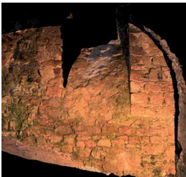
Ryc. 3.36. Iłża, fragment ruin zamku górnego – ortofoto ściany E piwnicy zamkowej – porównaj z ryc. 2.19 (oprac. fotogram. Politechnika Warszawska)
