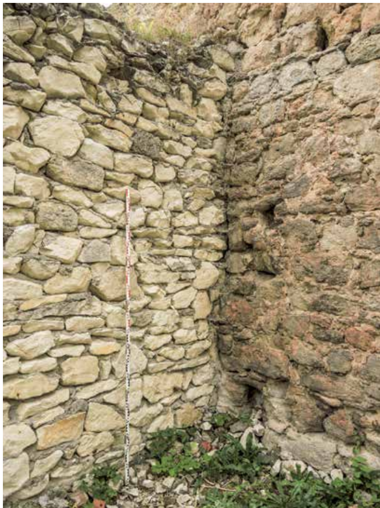
Ryc. 3.57. Ilża – fragment muru kurtynowego (prawa strona) i filaru mostowego (lewa strona), z widocznymi elementami przebudowy – rekonstrukcji (filar mostu) (fot. R. Zapłata – RZ)
