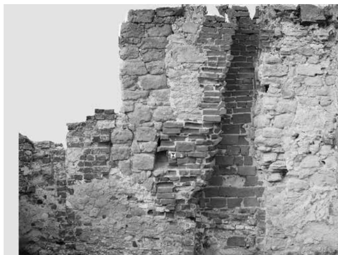
Ryc. 3.21. Ilża, fragment ruin zamku górnego. Zdjęcie cyfrowe powierzchni ściany N pomieszczenia nr I (wg lustracji z 1644 r.) – skala szarości. Stan na 2013 r. (porównaj ryc. 3.20). (fot. Politechnika Warszawska)
