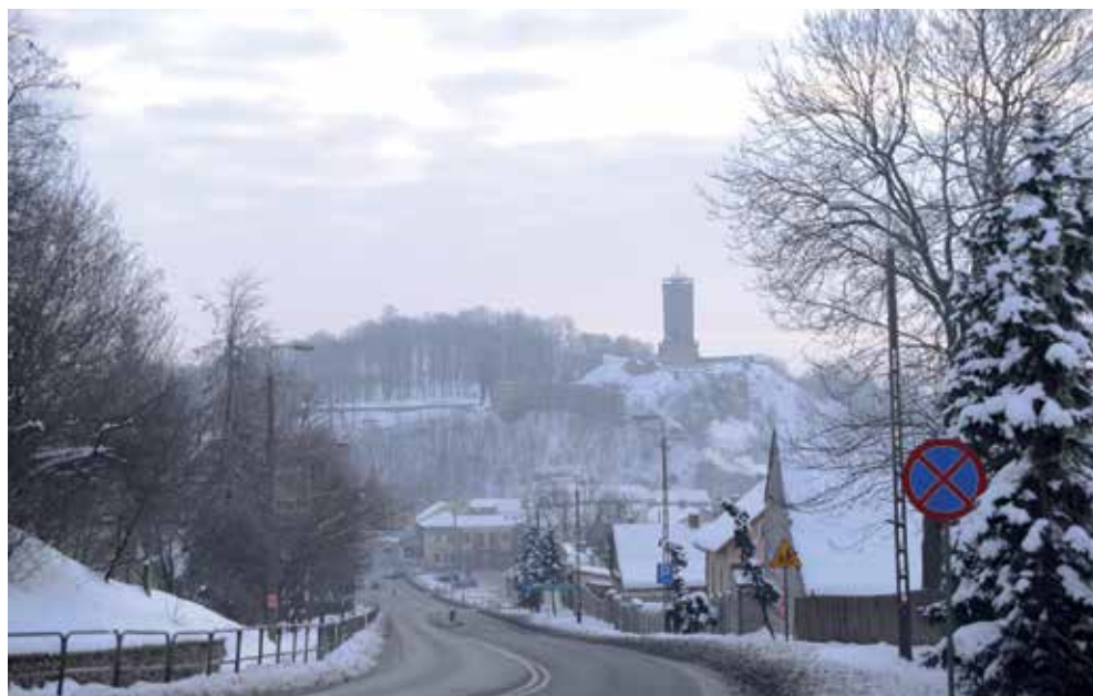
Ryc. 5.26. Wizualizacja korytarza widokowego w mieście Ilża (u góry) oraz zdjęcie z miejsca wykonywania analizy widoczności w kierunku wzgórza zamkowego od strony W (u dołu). Widok ze zbiegu ulic: Doktor Anki i Radomskiej. (pomiar MGGP Aero / oprac./fot. R. Zapłata)
