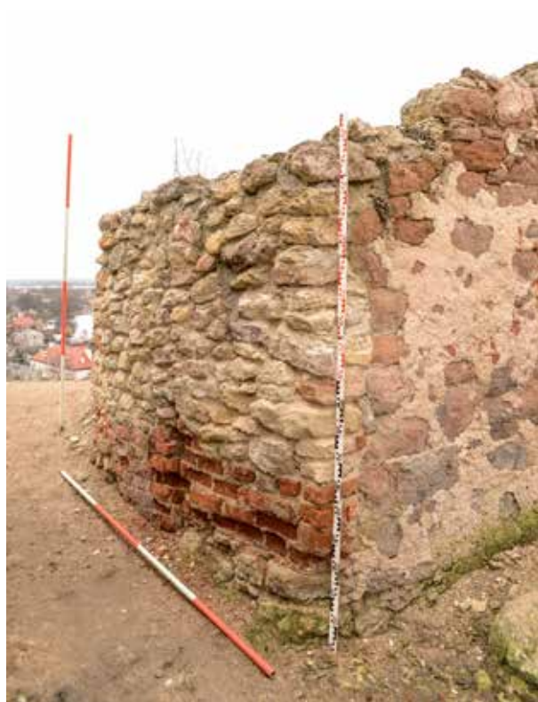
Ryc. 3.51. Iłża, zamek górny – ściana północna pomieszczenia nr 4. Widoczne liczne, luźno zalegające fragmenty kamieniarki renesansowej z piaskowca (fot. R. Zapłata – RZ)
