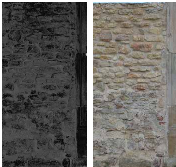
Ryc. 2.14. Ilża, ruina zamku górnego. Fragment elewacji z kamieniarką przy jednym z otworów komunikacyjnych – (po lewej) obraz intensywności odbicia wiązki lasera w skali szarości, (po prawej) zdjęcie cyfrowe. (Oprac. fotogram. Politechnika Warszawska / foto. R. Zapłata)
