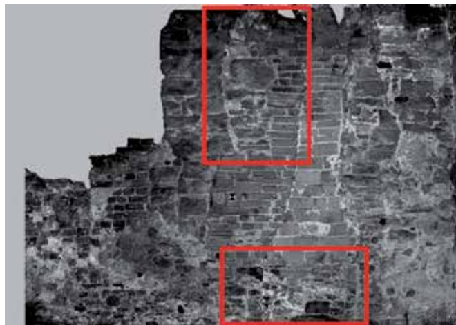
Ryc. 3.20. Ilża, fragment ruin zamku górnego. Ortofoto powierzchni ściany N pomieszczenia nr I (wg lustracji z 1644 r.) na bazie pomiaru naziemnym skanerem laserowym (fazowym). Obraz intensywności odbicia wiązki lasera w skali szarości m.in. z zaznaczonymi wykwitami soli (dolne zakreślenie) oraz słabo rozpoznawalnymi fragmentami muru (górne zakreślenie) – zaprawa oraz wapień. Stan na 2013 r. (oprac. Politechnika Warszawska)
