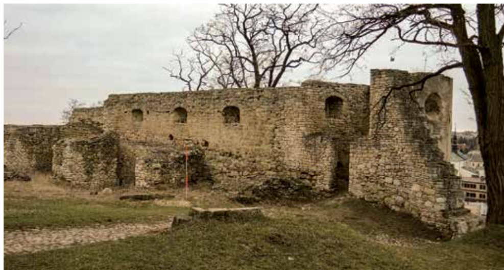
Ryc. 3.3. Ilża, ruina zamku – pozostałości muru kurtynowego (XVI w.), wapień łączony zaprawą wapienno-piaskową. Widok os trony NE (fot. R. Zapłata / RZ)
