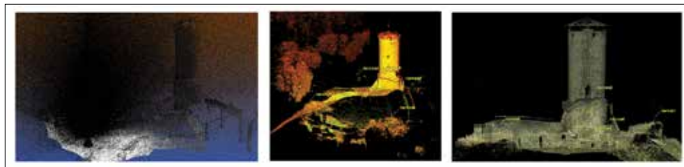
Ryc. 2.11. Ilża, ruina zamku górnego. Wizualizacja chmury punktów (widok od strony W) wygenerowana na bazie naziemnego skanowania laserowego – od lewej chmura punktów (1) przed filtracją, (2) po filtracji (z intensywnością odbicia wiązki lasera) oraz (2) z nałożoną teksturą (oprac. fotogram. Politechnika Warszawska oraz Leica Geosystems; oprac. R. Zapłata)
