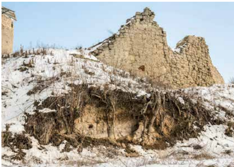
Ryc. 3.12. Iłża, zamek górny – przekrój przez warstwy przylegającego do muru zewnętrznego nasypu pod tzw. „oknem biskupim”; efekt procesów osuwiskowych i niszczącej działalności korzeni roślin dziko rosnących na terenie wzgórza. Widok od strony NW (fot. R. Zapłata / RZ/LK)
