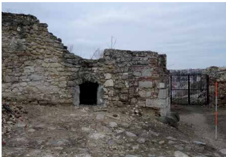
Ryc. 3.39. Widok na mur zewnętrzny dziedzińca zamkowego – ściana piwnicy. Widok od strony E (fot. R. Zapłata)
