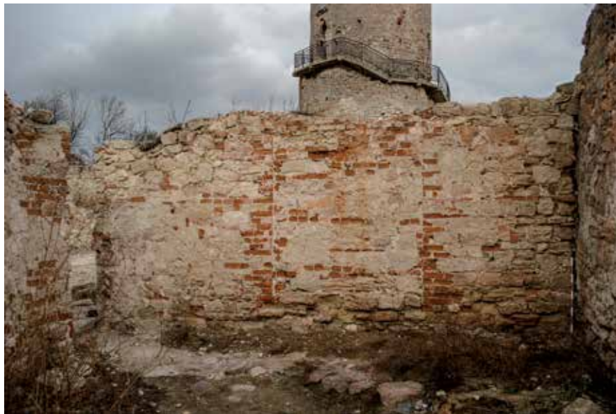
Ryc. 3.55. Iłża, zamek górny, ściana pomieszczenie nr 4 (wg Lechowicza, 2009), smolarni (wg lustracji z 1644 roku), rejterady (wg lustracji z 1789 roku) w części południowej założenia, wzniesiona z kamienia wapiennego i cegły, spojonych zaprawą wapienno-piaskową (XVI w.), z widocznym zamurowanym przejściem do następnego pomieszczenia, widok od zachodu (fot. R. Zapłata – RZ)
