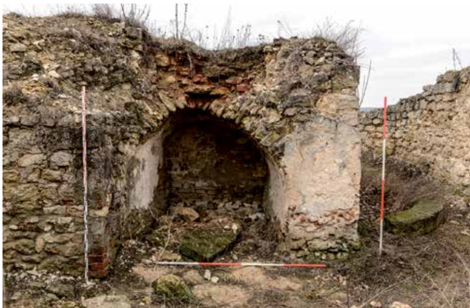
Ryc. 3.7. Ilża, zamek górny, wnęka sklepią kolebkowo w jednym z pomieszczeń (skarbcu – wg lustracji z 1644 i 1789 roku) po stronie północnej (XVI w.), wapienie i cegły, pozostałości fragmentarycznie zachowanych tynków / pobiał i warstwy malarskiej; widok od północy; fragment kamieniarki renesansowej luźno zalegający w pomieszczeniu; widoczne działania zabezpieczające mur; przykład stopniowego niszczenia muru i powstawania ubytków, w wyniku procesów rozsadzania surowca – ciosy wapienne i cegły niszczą przede wszystkim w wyniku przedostawania się wody do wnętrza budulca, przy współudziale zmieniającej się temperatury oraz rozrastającej się roślinności; zdjęcie ilustruje również proces deponowania się materiału odpadowego; kolebkowo sklepią stanowi przykład nielicznie zachowanych sklepień zabytkowych obiektu (fot. R. Zapłata / RZ/LK)
