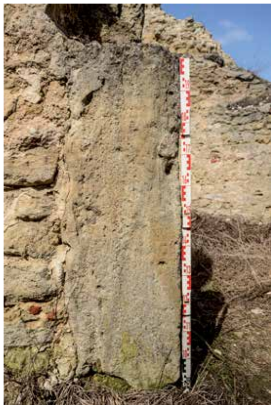
Ryc. 3.53. Ilża, zamek górny – fragment kamieniarki (węgar boczny) w otworze komunikacyjnym skarbca wg lustracji z 1644 r. (fot. R. Zapłata – RZ)
