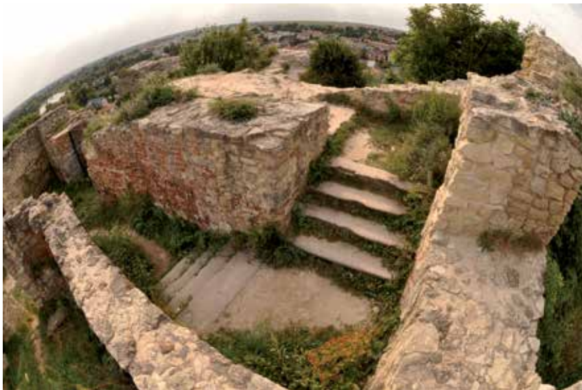
Ryc. 3.10. Iłża, zamek górny, pozostałości nowożytnej klatki schodowej prowadzącej na niezachowane piętro (XVI w.). Surowiec – cegła / ciosy wapienne / piaskowiec jasnobieżowy oraz współczesne uzupełnienia. Widok od NE (fot. R. Zapłata / RZ)
