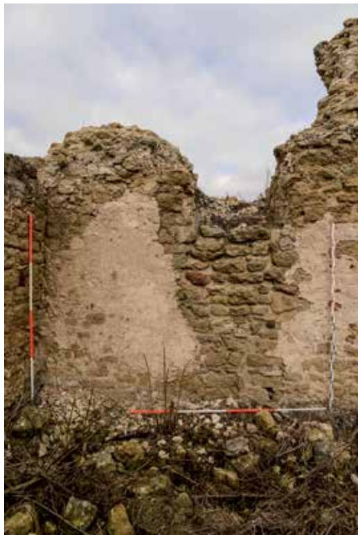
Ryc. 3.49. Ilza, zamek górny – fragment ściany zachodnio-północnej pomieszczenia – skarbcza wg lustracji z 1644 r.; wapień łączony zaprawą wapienno-piaskową, w układzie warstwowym, widoczne pozostałości tynku z późniejszych okresów związanych z remontami zamku (fot. R. Zapłata – RZ)
