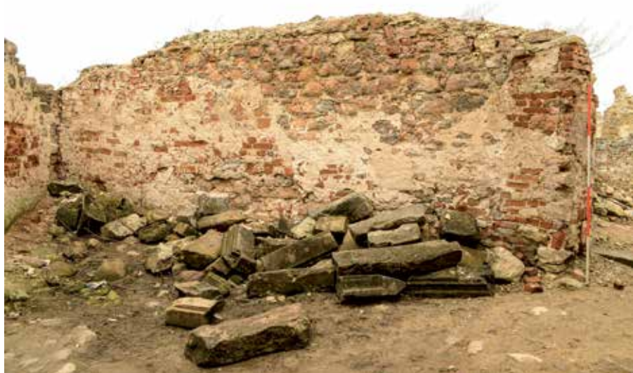
Ryc. 3.51. Iłża, zamek górny – ściana północna pomieszczenia nr 4. Widoczne liczne, luźno zalegające fragmenty kamieniarki renesansowej z piaskowca (fot. R. Zapłata – RZ)
