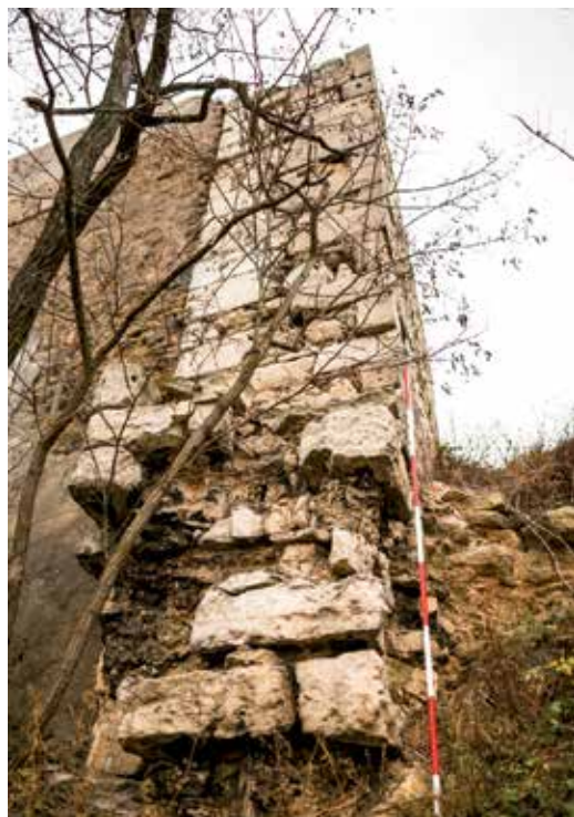
Ryc. 3.4. Iłża, ruina zamku – wschodnie pozostałości muru kurtynowego (XVI w.), wapień łączony zaprawą wapienno-piaskową. Widok od strony W / od strony miasta (fot. R. Zapłata / RZ)
