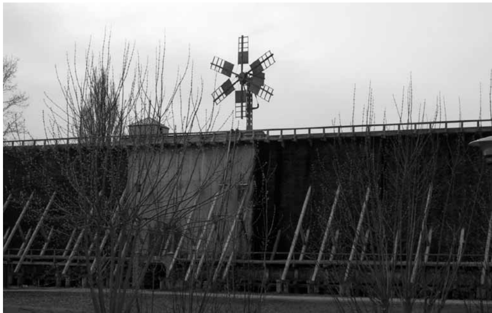
2. Pierwotnie solanka była pompowana na szczyt tężni przy użyciu wiatraków i maszyny parowej. Na zdjęciu wiatrak na tężni nr 2. Fot. A. Nocna
