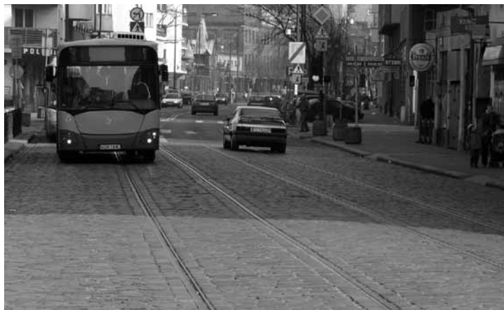
4. Warszawa, ul. Żąbkowska. Odbudowany tor tramwajowy w bruku, marzec 2008 r. Fot. T. Pieńkowski
