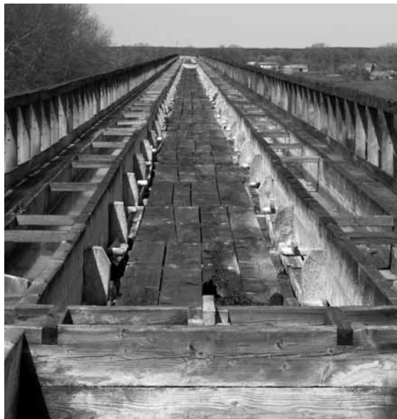
6. Koryta do solanki na górnym poziomie tężni nr 1. Fot. A. Nocna
