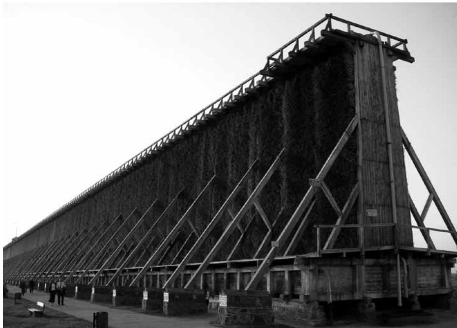
8. Tężnia nr 3 wzniesiona w 1859 r. ma zastrzały wsparte na podmurówce kamienno-ceglanej. Fot. A. Nocna
