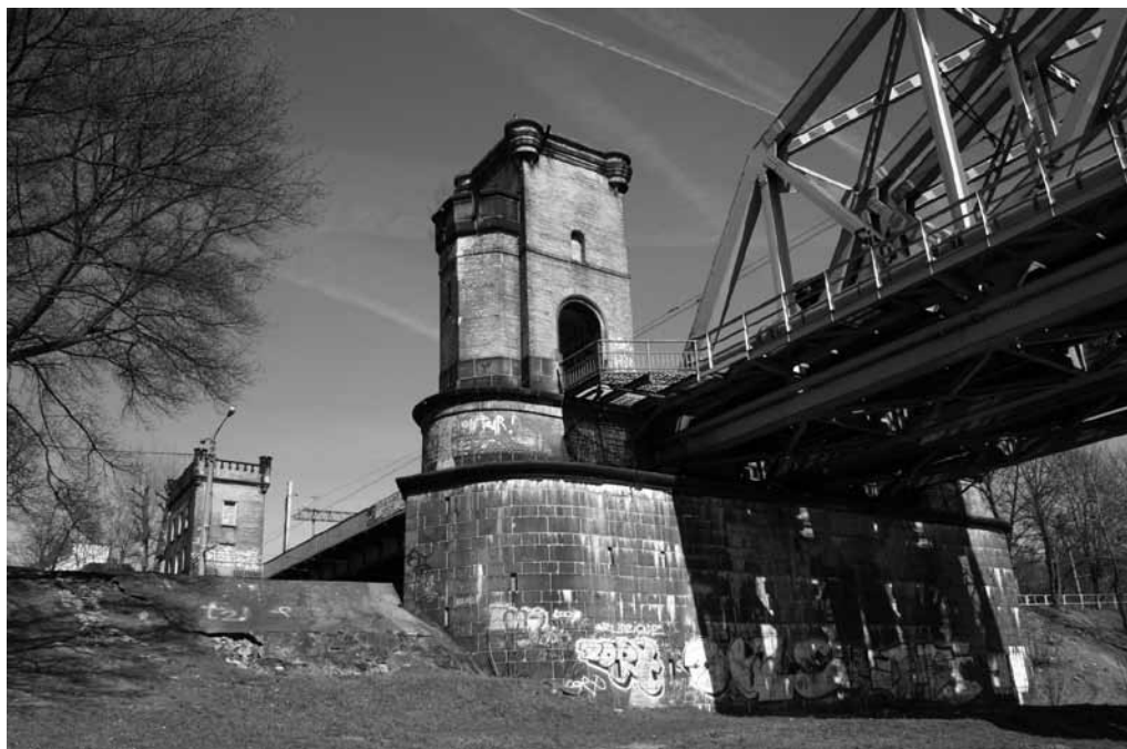
3. Toruń — most kolejowy, kwiecień 2009 r. Fot. R. Kola
