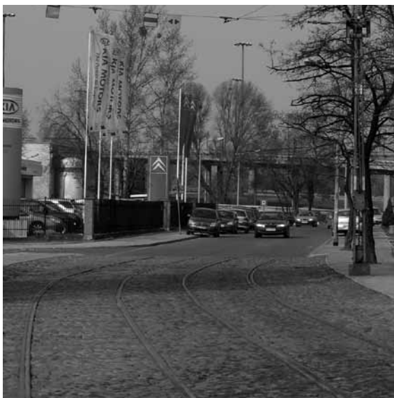
5. Warszawa, ul. Wysockiego. Relikt dawnego torowiska, marzec 2008 r. Fot. T. Pieńkowski
