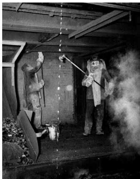
8. Piecownia periodyczna — naprawa murarska wewnątrz retort; szamotownie ubytków (l. 30. XX w.). Fot. z archiwum PGNiG
