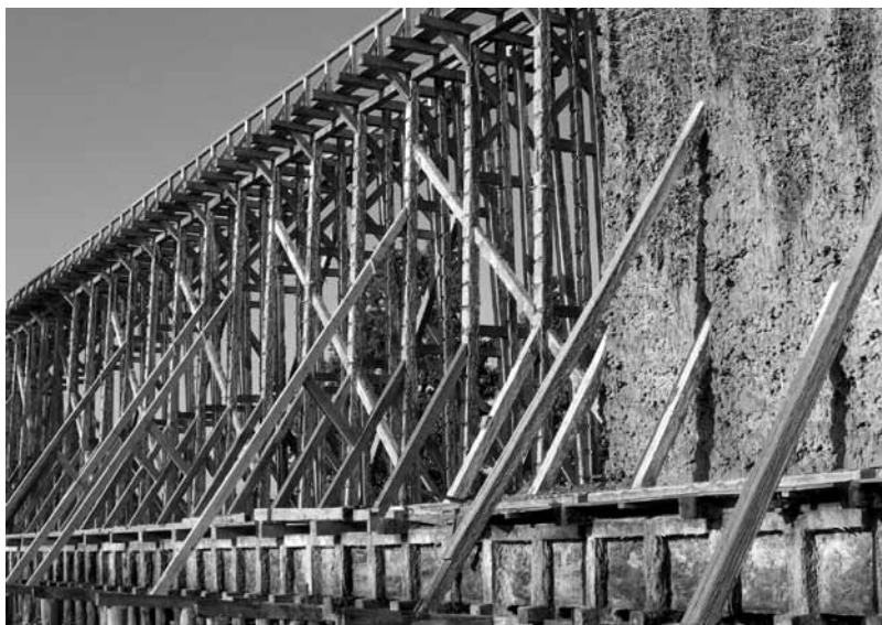
4. Trwający od kilku lat remont tężni nr 2 umożliwia obejrzenie wnętrza konstrukcji obiektu. Fot. A. Nocna
