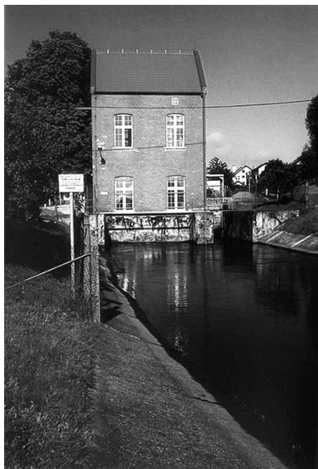
6. Elektrownia Pruszcz I
