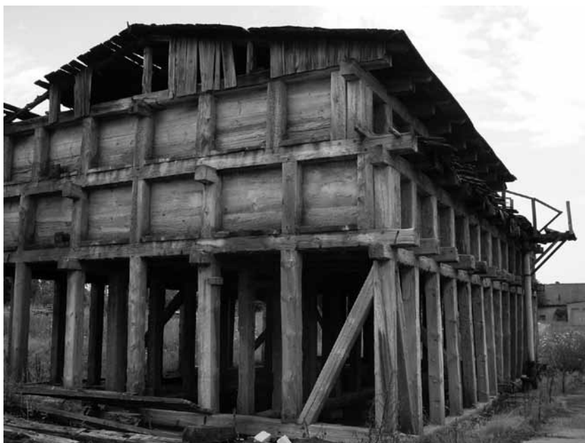
10. Rezerwuar solanki przy warzelni soli. Fot. A. Nocna
