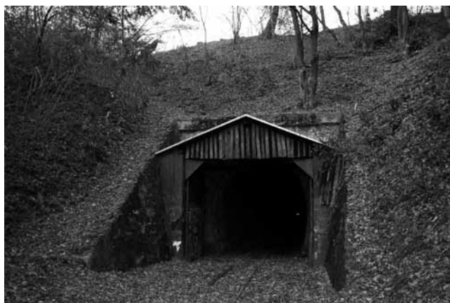
2. Tunel – portal południowy w Szklarach. Fot. A. Sapeta
