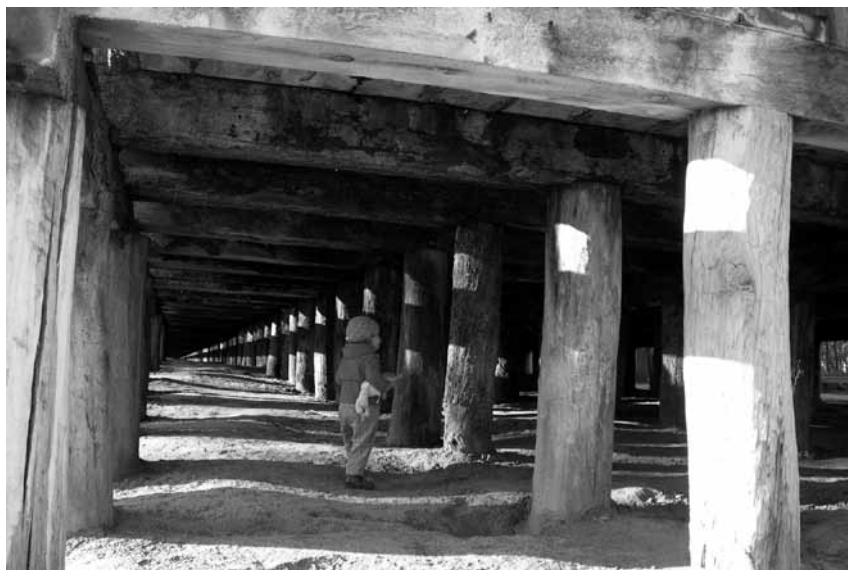
7. Cała konstrukcja tężni wspiera się na palach dębowych. Fot. A. Nocna
