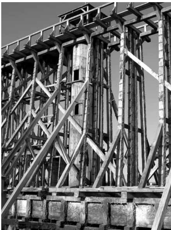
5. Remont tężni nr 2 pozwolił poznać jej przemysłną konstrukcję. Fot. A. Nocna
