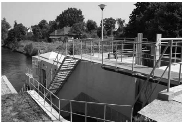
7. Elektrownia Pruszcz II
