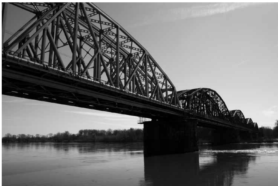
2. Toruń — most kolejowy, kwiecień 2009 r. Fot. R. Kola
