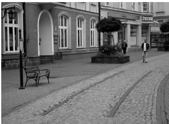
7. Tarnów, ul. Wałowa. „Tor tramwajowy” wykonany z kostki brukowej. Maj 2008 r. Fot. T. Pieńkowski
