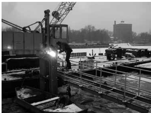
1. Budowa stanowiska cumowniczego, 2001 r. Fot. S. Januszewski
