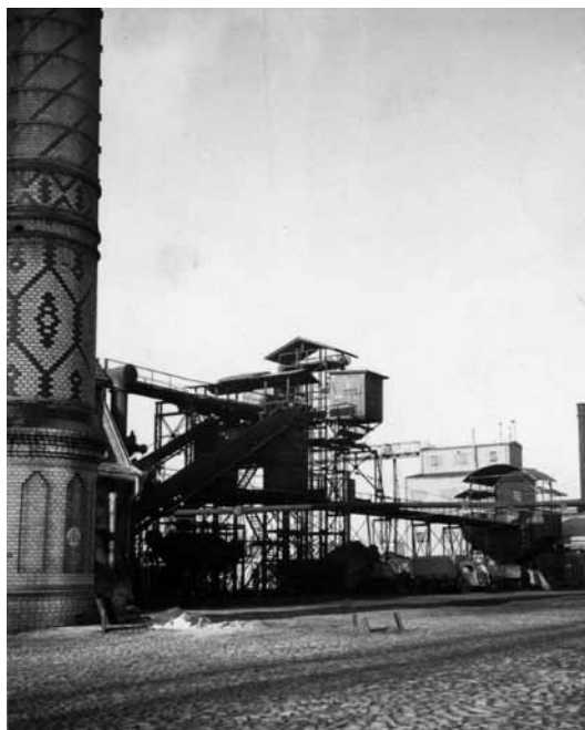
10. Sortownia koksu przy piecowni okresowej (1951 r.). Fot. z archiwum PGNiG
